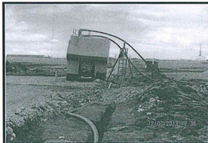
Fotografía N° 28: Hallazgo N° 1 Plataforma de Perforación PTF 056. En la supervisión se constató el carguío de lodos de perforación al camión cisterna en el punto denominado la "Garza".
