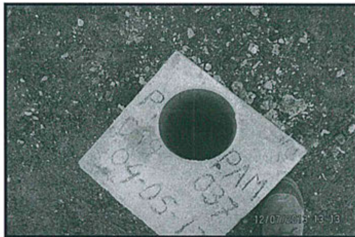
Fotografía N° 46. Hallazgo N° 3 Sondaje de Perforación Diamantina PAM-037. Vista fotográfica del dado de concreto del sondaje diamantino PAM-037. Se constató que la boca del sondaje no está sellado.
