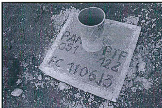
Fotografía N° 48. Hallazgo N° 3 Sondaje de Perforación Diamantina PAM-051. Vista fotográfica del dado de concreto del sondaje diamantino PAM-051 ubicado en la Plataforma de Perforación Diamantina PTF-122. Se constató que la boca del sondaje no está sellado.
