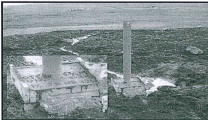
Fotografía N° 37. Hallazgo N° 3 Plataforma de Perforación PTF-012. Vista fotográfica del dado de concreto indicando como fecha de cierre el 25 de agosto de 2012. También se observa, la canaleta por donde el agua proveniente del sondaje diamantino es derivada al exterior de la plataforma de perforación.
