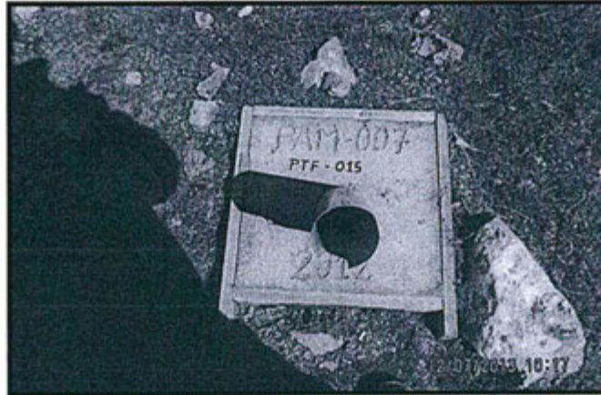
Fotografía N° 41. Hallazgo N° 3 Sondaje de Perforación Diamantina PAM-007. Vista fotográfica del dado de concreto del sondaje diamantino PAM-007. Se constató que la boca del sondaje no está sellado.
