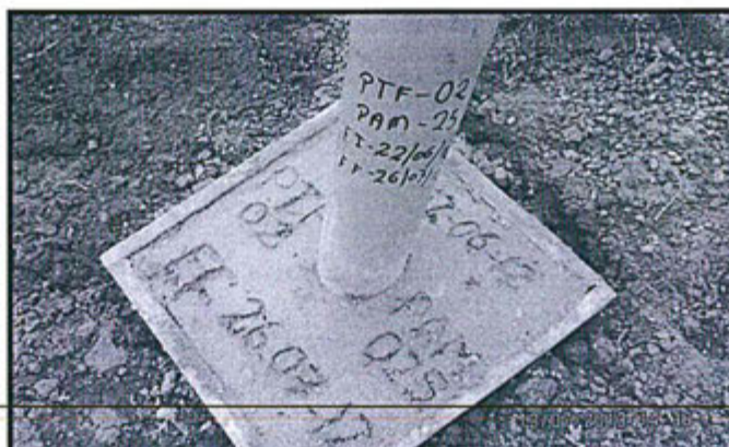
Fotografía N° 51. Hallazgo N° 3 Sondaje de Perforación Diamantina PAM-025. Vista fotográfica del dado de concreto del sondaje diamantino PAM-025 ubicado en la Plataforma de Perforación Diamantina PTF-02.
