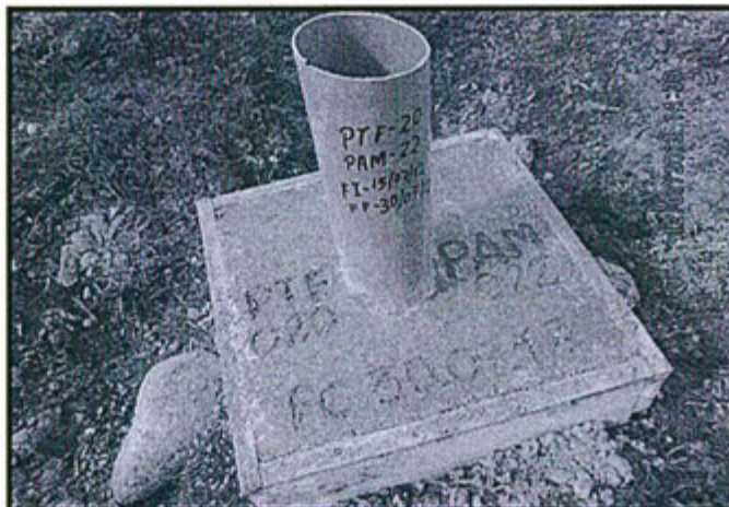
Fotografía N° 50. Hallazgo N° 3 Sondaje de Perforación Diamantina PAM-022. Vista fotográfica del dado de concreto del sondaje diamantino PAM-022 ubicado en la Plataforma de Perforación Diamantina PTF-020. Se constató que la boca del sondaie no está sellado.
