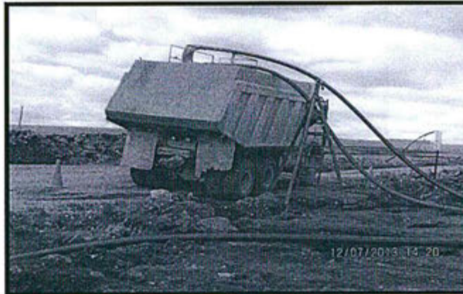
Fotografía N° 29: Hallazgo N° 1 Plataforma de Perforación PTF 056. Se constató el carguío de lodos de perforación al camión cisterna, provenientes de la plataforma de perforación.
