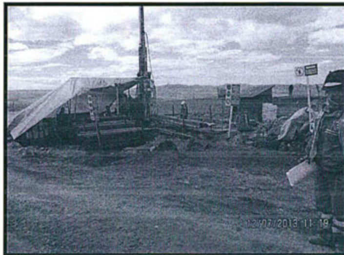
Fotografía N° 25: Hallazgo N° 1 Plataforma de Perforación PTF 056. Vista panorámica de la plataforma de perforación PTF 056, ubicada en las coordenadas UTM Datum WGS 84 Zona, 8 820 415N y 347 318E.
