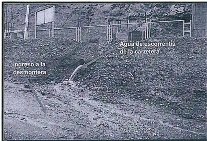
Fotografía N° 35: Tubería de descarga de agua de escorrentía, ocasionando erosiones y arrastre de materia hacia el talud de la desmontera Colquicocha
