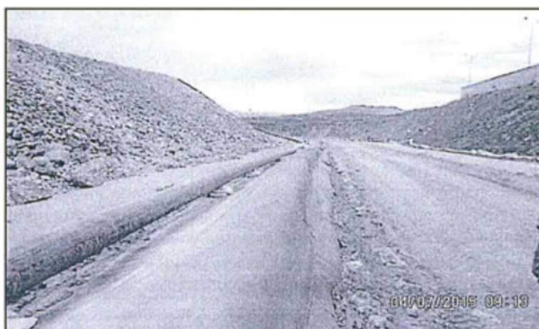
"Fotografía N° 06. Vista del talud del pad de lixiviación".
