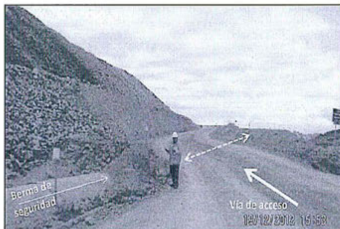
Fotografía N° 70: Observación 6-2012, área del pad de lixiviación se verificó que un acceso corta la berma perimetral, además este acceso no se encuentra contemplado en el EIA de La Zanja.
