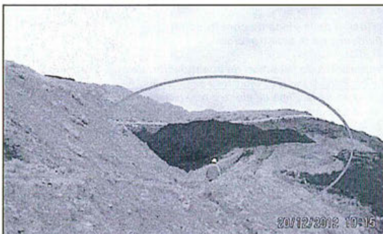
Foto N° 79: Observación N° 11-2012, en el área del tajo Pampa Verde, ubicado en las coordenadas UTM datum WGS84: E 730409, N 9245771 se encontró la disposición de suelo orgánico (Top Soil), sin las medidas de protección ambiental. Asimismo, este lugar no corresponde para almacenamiento de Topsoil.
