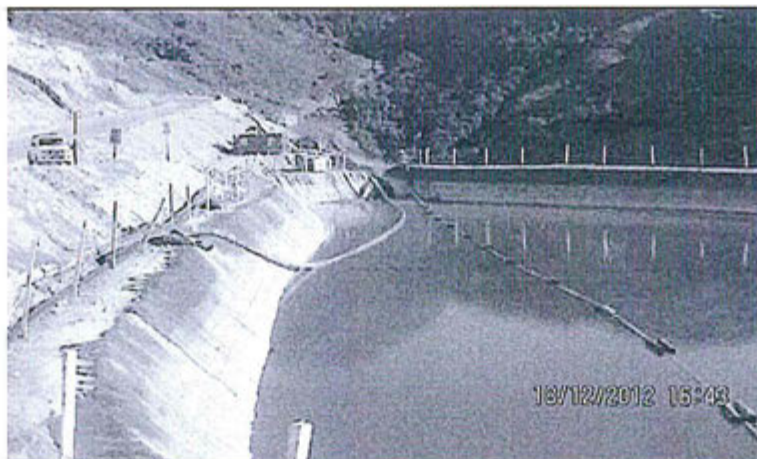
Foto N° 7: Vista de la Poza de Sedimentación N° 12, ubicada en las coordenadas UTM y datum WGS84: E 731506 y N 9244475, captación de aguas de escorrentía.
