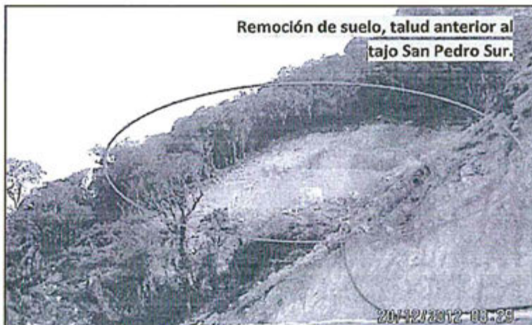
Foto N° 75: Observación N° 09-2012, área del talud del Tajo San Pedro Sur, se evidencio arrastre de material, generado por la remoción de suelo.
