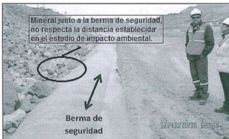
Foto N° 69: Observación N° 05-2012, se verificó el mineral del pad junto a la berma de seguridad.
