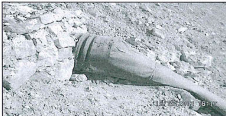
Foto N° 5: Área del tajo San Pedro Sur, vista del sistema de conducción de las aguas de escorrentía hacia las pozas de sedimentación ubicadas en la parte inferior del nivel de la plataforma del tajo.
