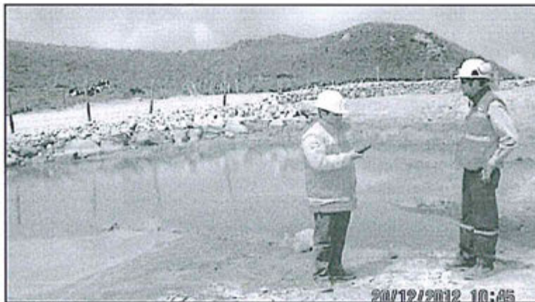
Foto N° 82: Observación N° 12-2012, poza de captación de drenaje del depósito de top soil, el cual no contaba con base impermeabilizada para evitar las filtraciones en el suelo.
