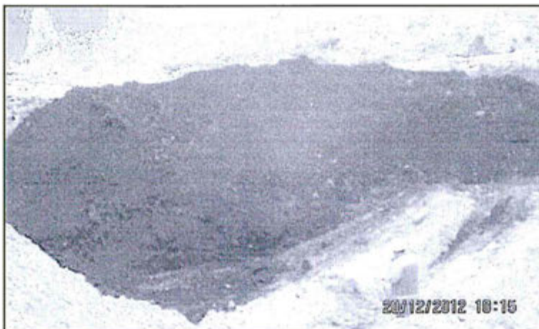
Foto N° 80: Observación N° 11-2012, Disposición de suelo orgánico (top soil) sin las medidas de protección ambiental. Asimismo, este lugar no corresponde a almacenamiento de top soil.
