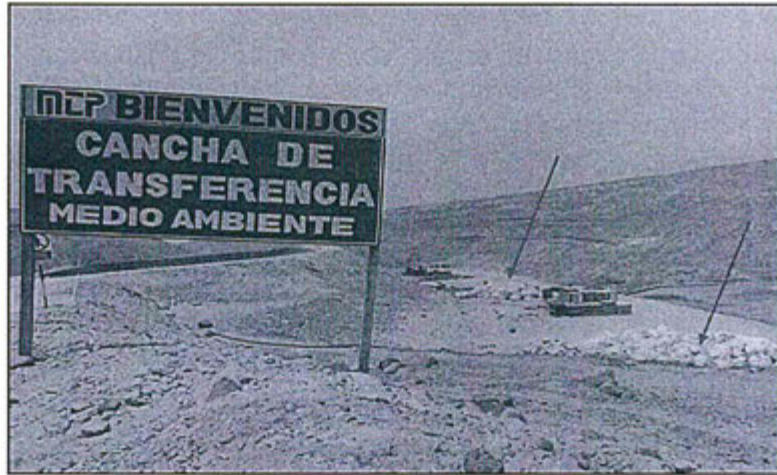
Fotografía N° 48.- Instalaciones de la cancha de transferencia donde se observa el almacenamiento inadecuado de residuos (bolsas de cianuro y otros), sobre el suelo sin protección.
