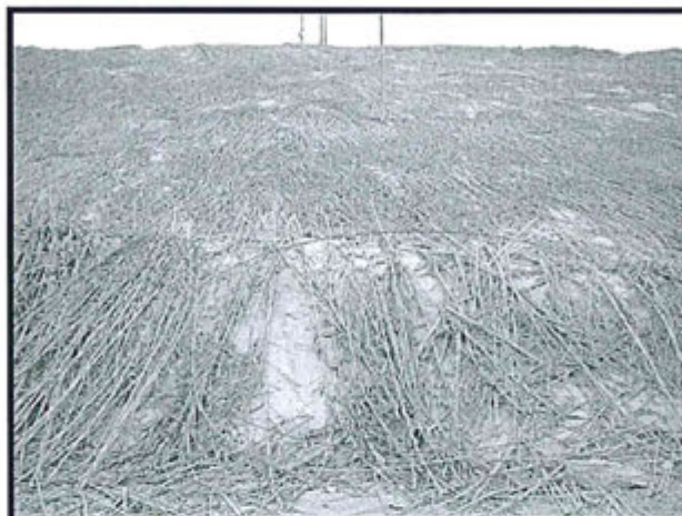
Foto N° 82: El talud del depósito de relaves N° 2 se encuentra cubierto con material de caña, faltando cubrir pequeñas áreas, para evitar que se disperse el material particulado; la titular deberá cubrir las partes faltantes.
