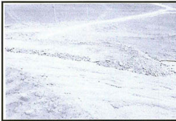
Vista desde parte superior donde se muestra el relleno con desmonte (actualmente implementándose) encima del muro de contención ya existente
