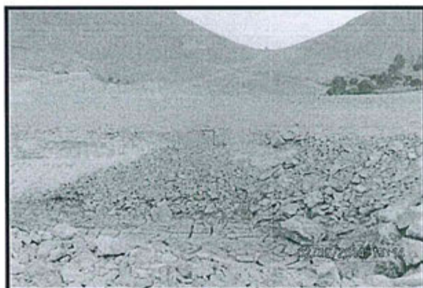
Fotografía N° 2: Depósito de relave N° 2. Cerrado con cobertura de 0.50 m de material de préstamo
