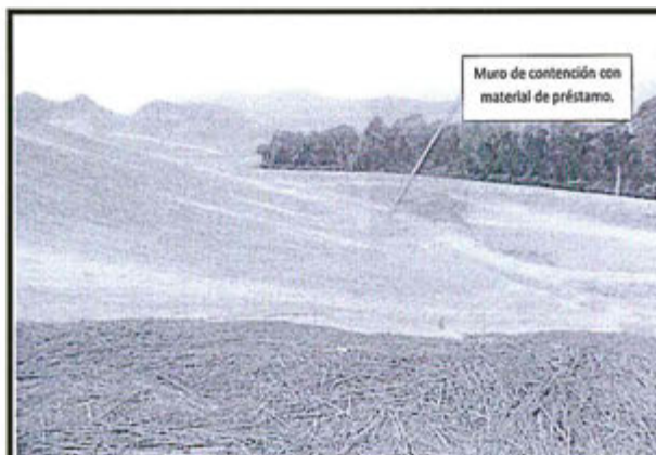
Vista panorámica de Sur a Norte del pie de cancha de relaves N° 3
