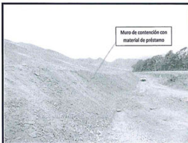
Muro de contención e pie de cancha de relaves N° 3
