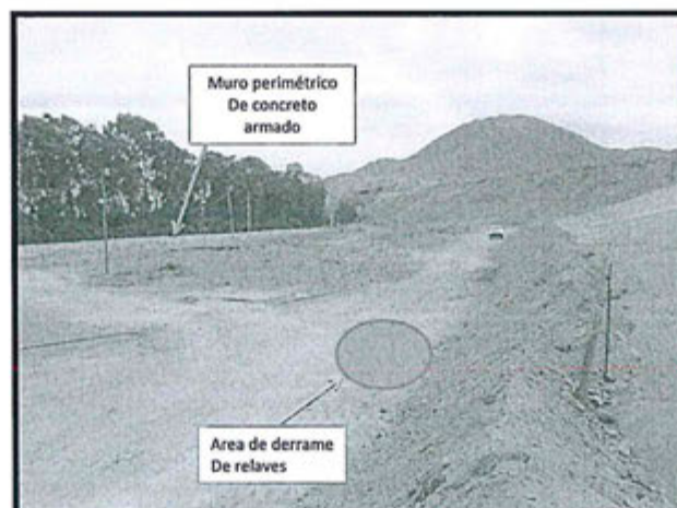
Vista al este, desde el muro de contención hacia el muro perimétrico de concreto
