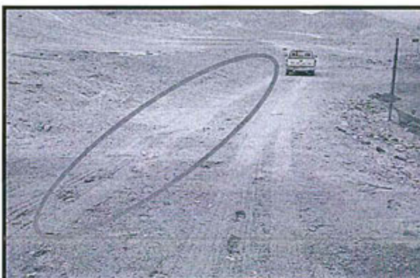
Foto N° 78: El talud del depósito de relaves N° 3 no cuenta con un muro de contención que permita un mejor manejo operativo de la disposición de relaves: la empresa deberá construir un muro de contención.
