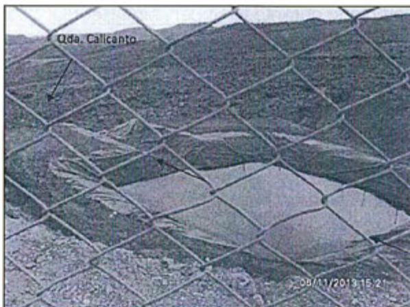
Fotografía N° 120 del Informe de Supervisión: Hallazgo 1 – Poza de monitoreo de subdrenaje del depósito de desmontes N° 1, lugar donde se produce el vertimiento no autorizado del efluente minero a la Quebrada Calicanto
