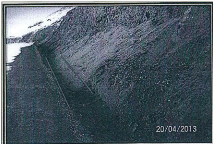
Foto Hz-24.- Camino circundante del Pad Room I en donde se puede apreciar el canal de coronación invadido.
