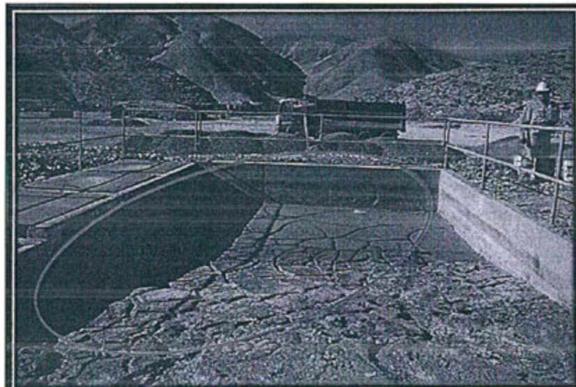
Foto Hz-12.- Se aprecia la zona de lavado en el taller de mantenimiento con lodo contaminado con grasa y aceite sin recoger y llevado al lugar previsto para ellos.
