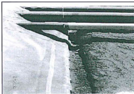
Fotografía N° 9: La vista anterior mostrando con mayor detalle, la presencia de hidrocarburos impregnados en el piso del área estanca..
