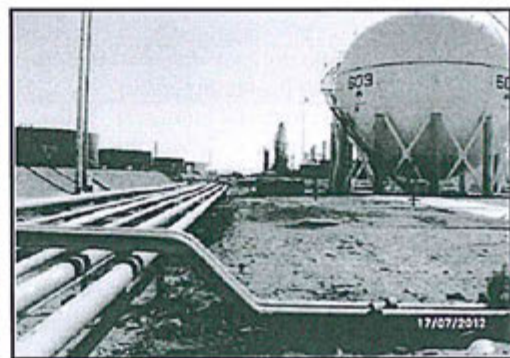
Fotografía N° 10: Tierra impregnada por crudo debajo del rack de tuberías y entorno a la escuadra ubicada al lado Sur Este del Tanque 603, en un área aprox. de 24 m² y 30 m² respectivamente
