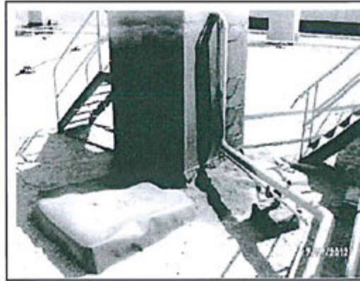
Fotografía N° 8: Piso impregnado con hidrocarburos en un área aprox. de 20 m² entorno a la línea de carga y descarga pegado al muro de contención, lado Sur del Tanque 545.
