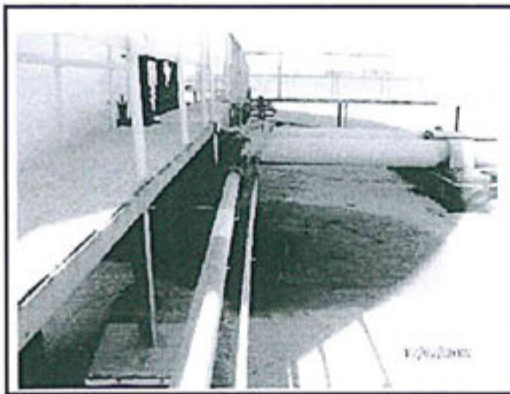
Fotografía N° 7: Piso impregnado con hidrocarburos debajo de la válvula de la tubería de entrada del Tanque 545, en un área de aprox. 6 m².
