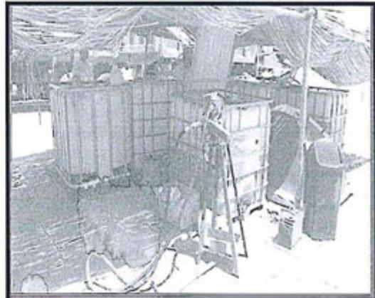
**Vista 6.** Grifo de combustible en la salida a la Panamericana Norte al costado del camino de acceso que Energía Eólica S.A. viene construyendo hacia el futuro Parque Eólico, se observó que dicha instalación no cuenta con un sistema de contención en caso de derrames de HC; (...)."
