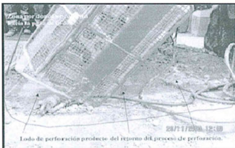
Fotografía N° 96.- Vista lateral del collar de la perforación, se observa el agua de la perforación (lodo de perforación) que es contenido en esta área sin impermeabilizar.
