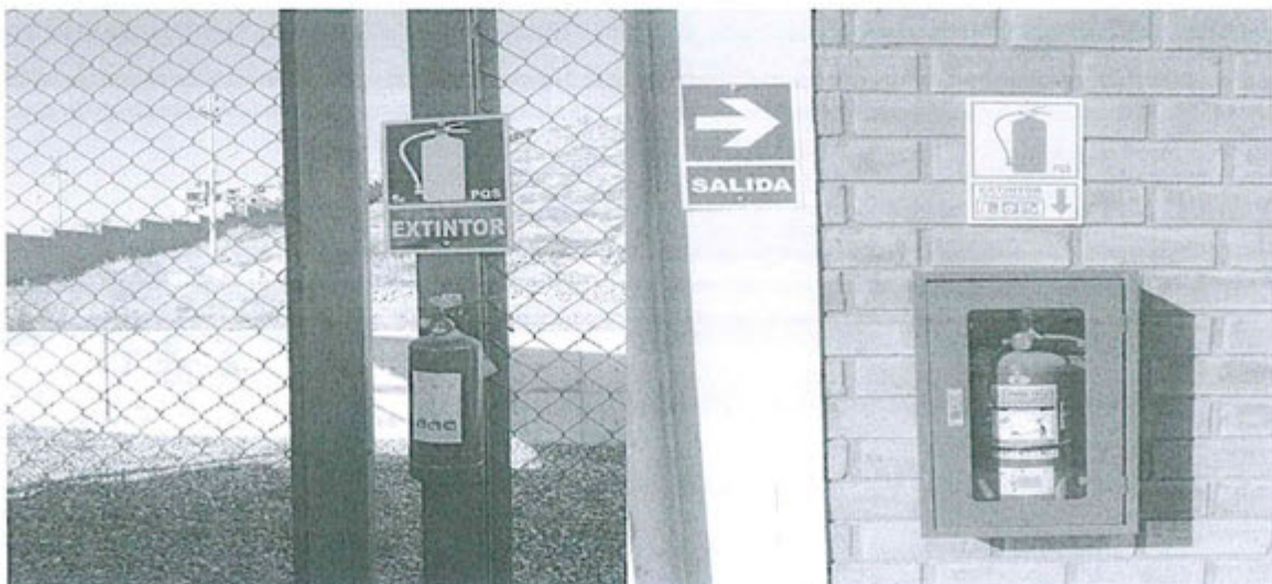
Fotografía 5 y 6: Ubicación y señalización de evacuación y extintores
