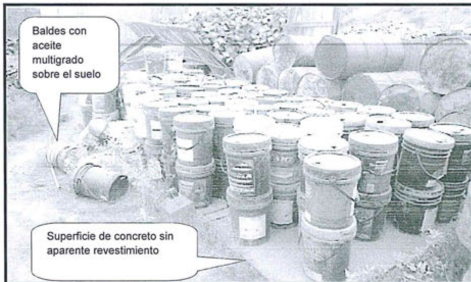
Fotografía N° 1: Vista de la SET Jesús donde se pueden observar baldes conteniendo aceites multigrados, estos se encuentran ubicados en suelo permeable y a la intemperie
