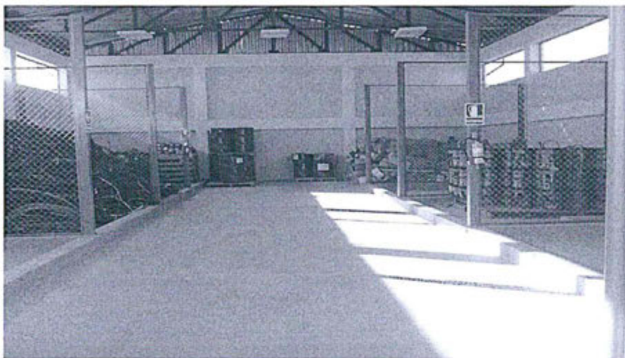
Fotografía 7: Almacén de residuos peligrosos con pasillos amplios para tránsito.
