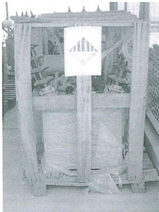
Fotografía 13: Señalización de Seguridad para almacenamiento de Transformadores
