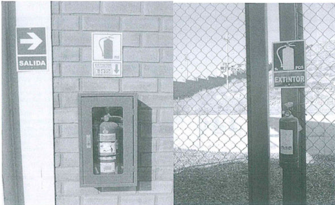
Fotografía 11 y 12: Ubicación y señalización de evacuación y extintores
