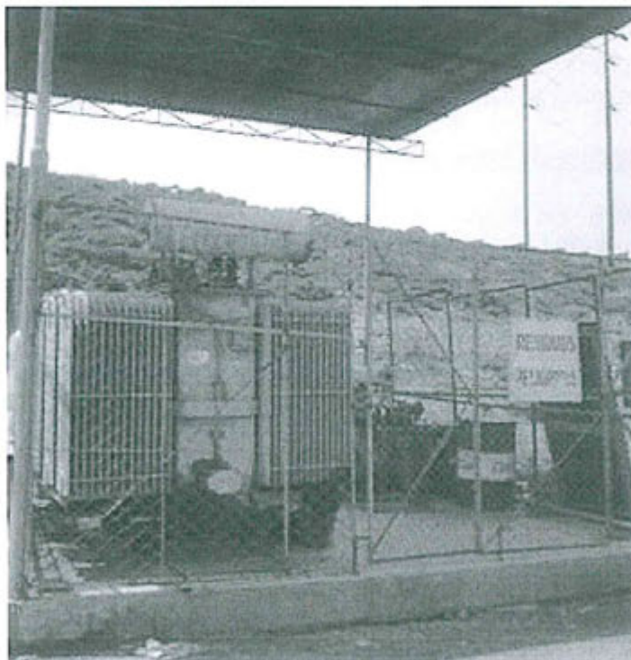
Fotografía 19: Señalización de Residuos Peligrosos
