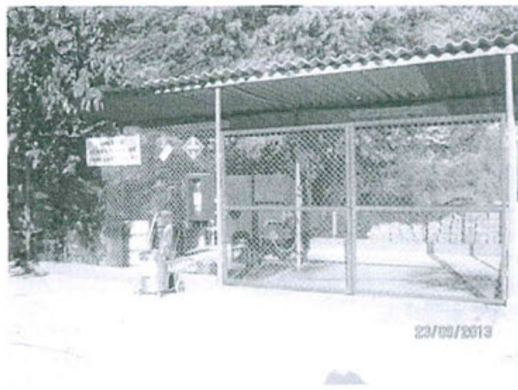
Vista 2 Malla de Fierro y Portón fe fierro para ingreso de personal
