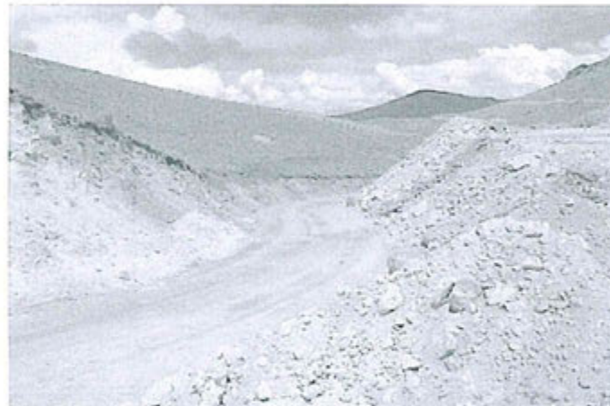
Fotografía 10: Parte superior del depósito de desmontes, no existe canal de conoración. La cuneta de la vía de acceso requiere mantenimiento.
