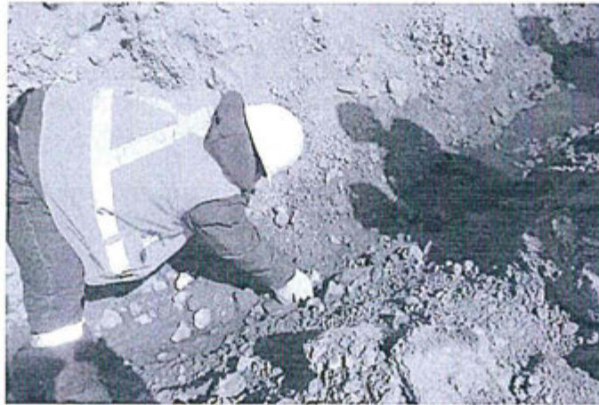
Fotografía 63: Filtraciones de aguas servidas del pozo séptico ubicado proximo al campamento.
