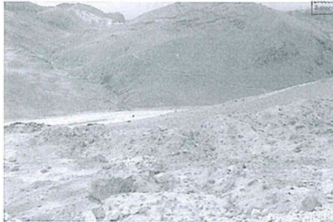
Fotografía 9: Lado derecho del depósito de desmontes, no existe canal de coronación.
