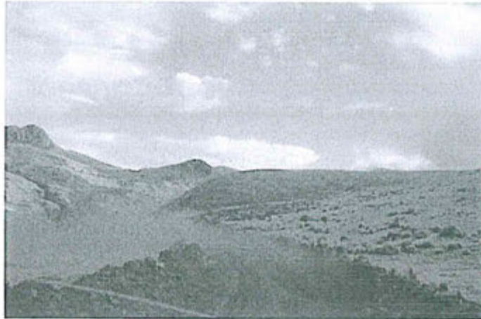
Fotografía 35: Vías de acceso construido por Anabi S.A.C. sin certificación ambiental. Se observa la emisión de polvos por el tránsito de vehículos.
