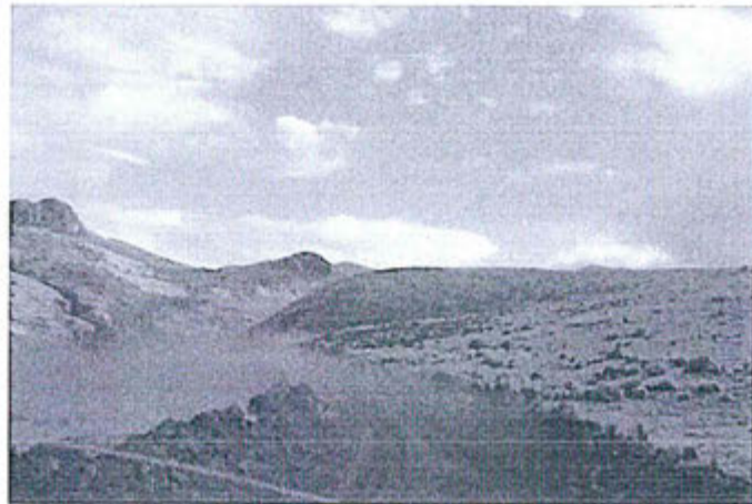
Fotografía 35: Vías de acceso construido por Anabi S.A.C. sin certificación ambiental. Se observa la emisión de polvos por el tránsito de vehículos.
