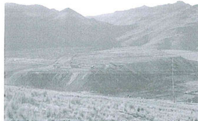
Fotografía 14: Pila de lixiviación, no cuenta con canal de coronación en la parte superior y un tramo de las partes laterales superiores.
