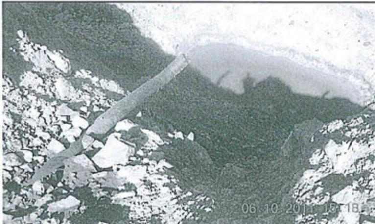
Fotografía N° 7: Vista superficial desde el borde la plataforma anterior, se observa al fondo la formación de una poza de agua contaminada, que se infiltra, y se mezcla con aguas subterráneas variando los niveles freáticos.
