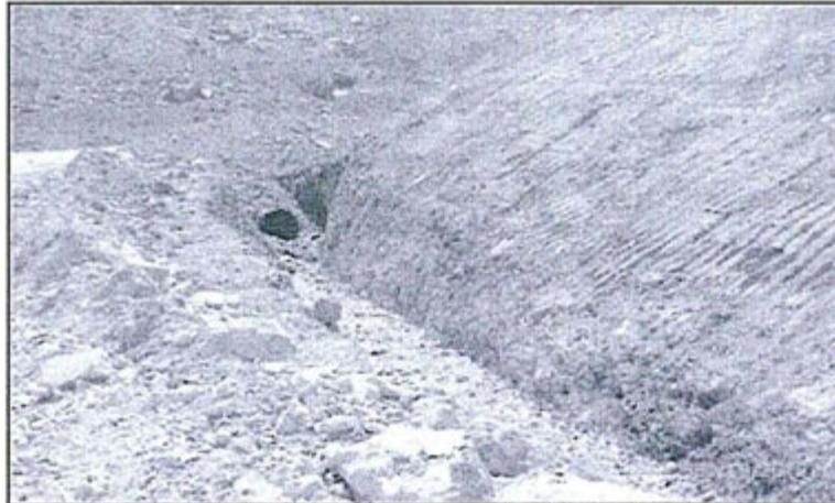
Fotografía N° 25: Tramo de acceso en el tajo abierto con estructuras permanentes de alcantarillas y cunetas de colección y transporte para derivación de aguas de escorrentía.
