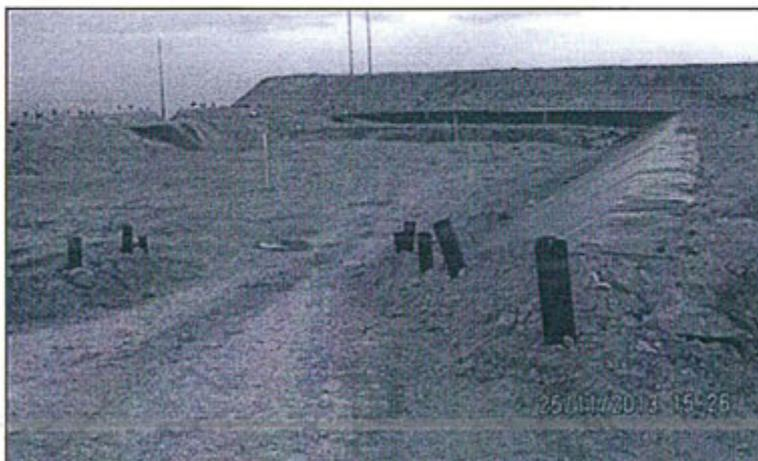
Fotografía N° 25 del Informe N° 402-2013-OEFA/DS-MIN: Relleno Sanitario de Residuos Domésticos, se aprecia acceso para vehículos y zona impermeabilizada.
