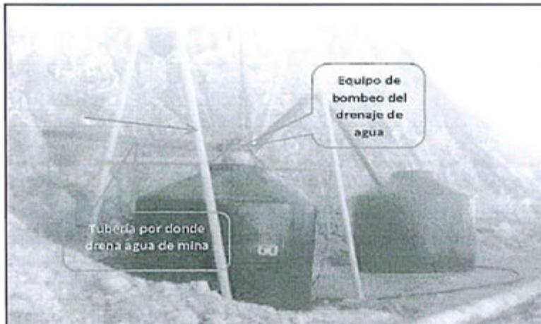
Fotografía N° 27: Sistema de captación y bombeo de agua que drena por la tubería en el nivel 3740 del tajo (cumplimiento de la Recomendación N° 2 de la Supervisión Regular 2011).
