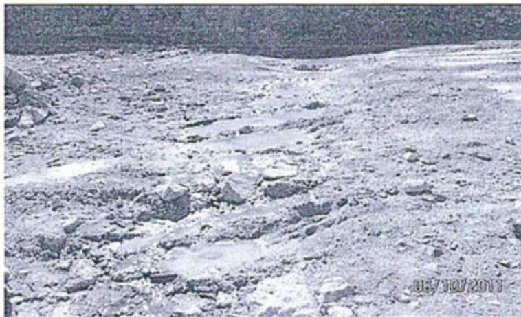
Fotografía N° 6: Plataforma donde discurre el flujo de agua a través de la plataforma del banco del tajo, se observa lixiviados ácidos con sedimentos.
