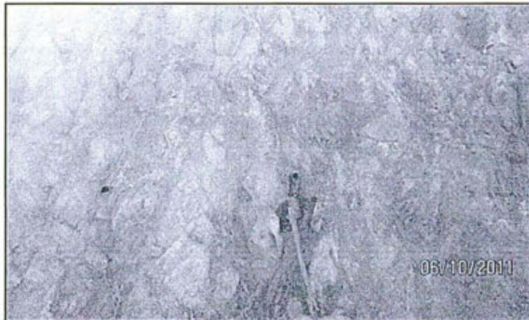
Fotografía N° 5: Interior del tajo, talud del banco sobre el Nv 3740 se observa flujo de agua subterránea a través de la corteza de las paredes del tajo por una tubería que discurre y a su paso se va infiltrando.
