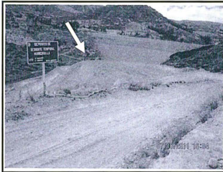
Fotografía N° 32.- Parte superior del depósito de desmontes Huinchulla
