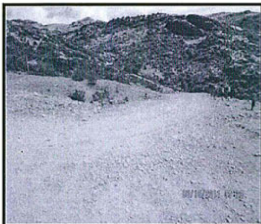
Fotografías N° 78 y 79.- Depósito de desmonte de la bocamina 3360. Nótese el canal de coronación incompleto y en suelo natural.
