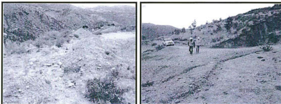
Fotografías N° 138 y 139.- Depósito de desmontes en el Nivel 3347
