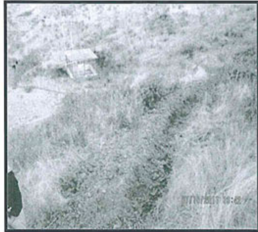
Fotografías N° 35 y 36.- Canal de coronación del depósito de desmonte del nivel 3315, en terreno natural e incumpliendo los parámetros de diseño.
