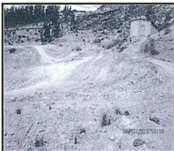
Fotografías N° 94 y 95.- Depósito de desmontes del Nivel 3415 sin canal de coronación.
