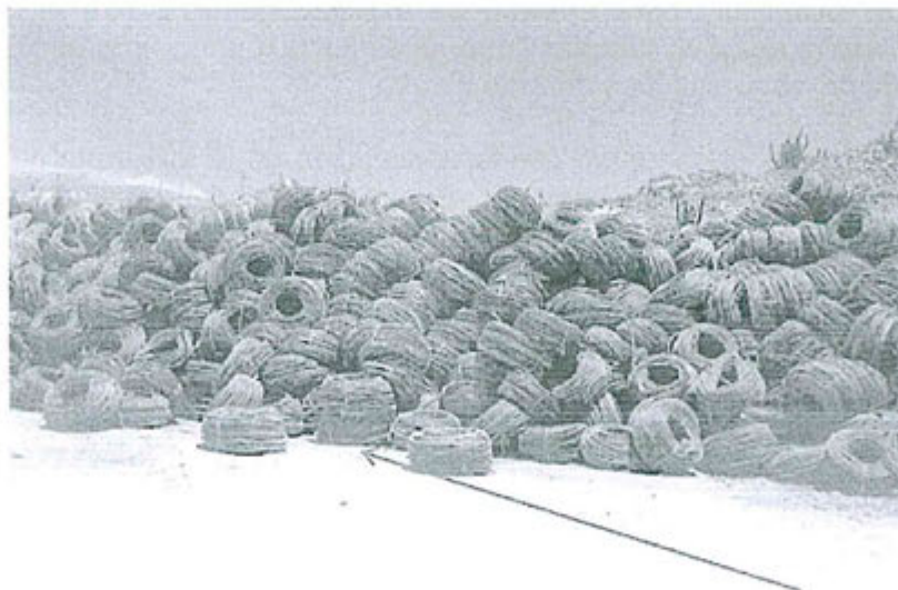
Fotografía N° 59.- Supervisión Regular 2012.- Observación N° 2.- Almacenamiento inadecuado de tuberías y mangueras perforadas se disponen sobre suelo natural sin las condiciones mínimas de almacenamiento y protección del ambiente.
