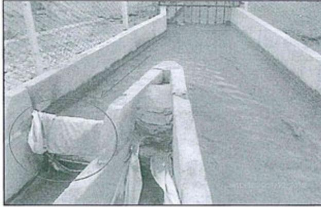
**Fotografía N° 15 del Informe de Supervisión:** Vista de la compuerta con derivación que puede descargar directamente en la laguna Tinquicocha durante la limpieza del sedimentador.
