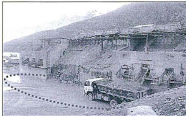
Fotografía N° 13 del Informe de Supervisión: Vista de la tolva para almacenamiento de mineral frente a la bocamina Hidro, presenta agua anegada con residuos de mineral y riesgo de afectar la laguna Cabalococho.
