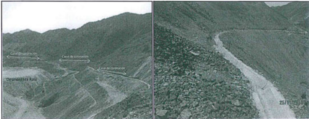
Fotografías N° 145 y 146: Desmontera Raúl y canal de coronación operativo
