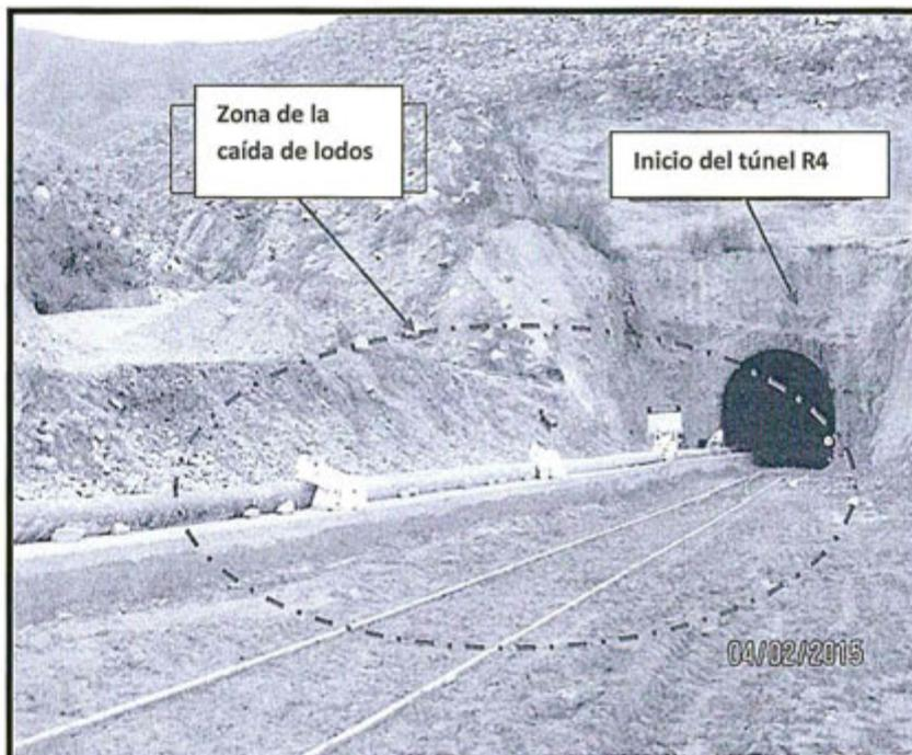
Fotografía N° 14: Vista de la zona donde ocurrió la caída de lodos que bloqueó la vía férrea en el inicio del túnel R4.
