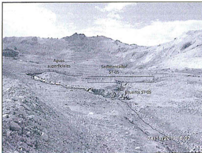
Fotografía 115: Hallazgo 2 – Punto en el cual se juntan indebidamente las aguas superficiales con el efluente ST-05
