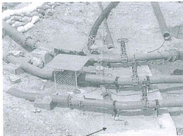
PISO DE CONCRETO ARMADO CON HUELLA DE LA LIMPIEZA
