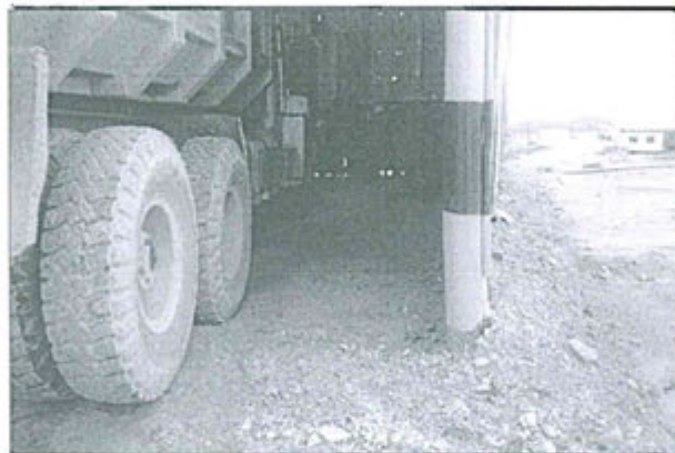
FOTO N° 11 Vista del taller de mecánica de la contrata MVS, obsérvese el piso sin impermeabilizar.
