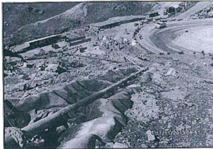
Fotografía 20: Tramo de tubería contenido en canal impermeabilizado
