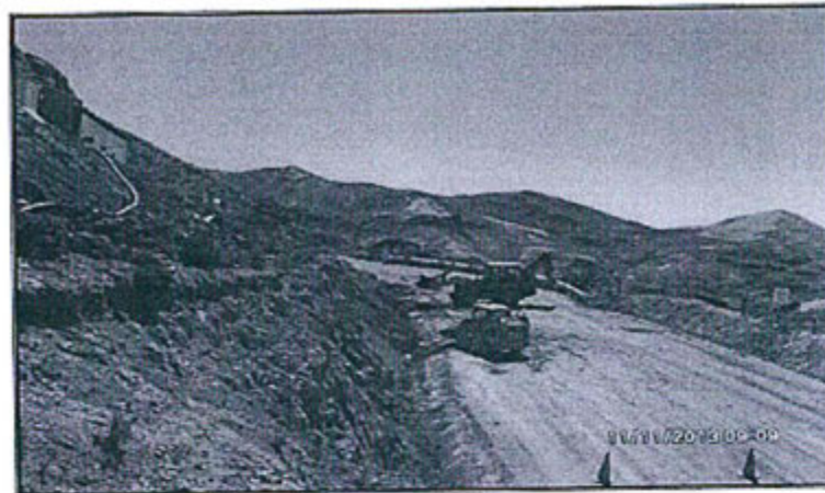
Fotografía 18: Payloader chico y Bob Cat en faena de limpieza de cunetas a 04 horas de ocurrido el evento
