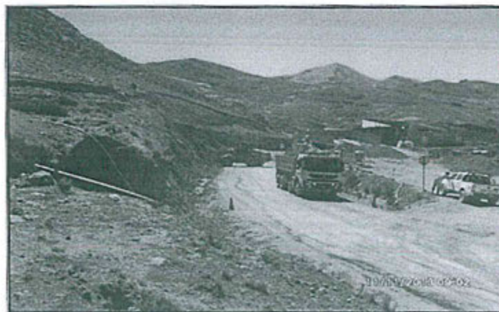
Fotografía 17: Payloader y camión en faena de limpieza de talud y cunetas a 04 horas de ocurrido el evento
