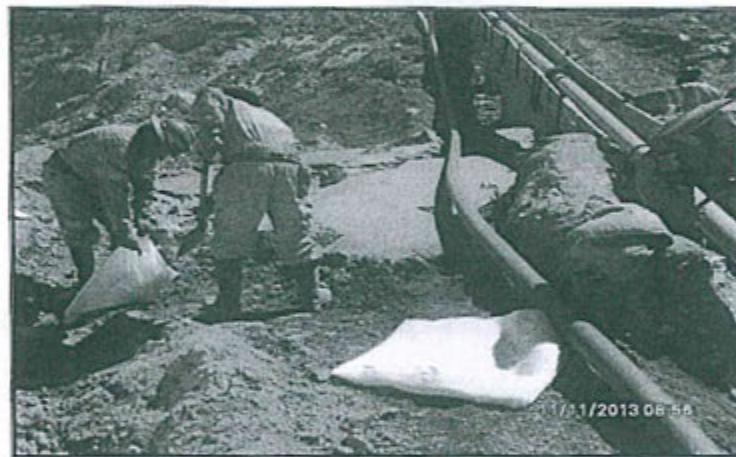
Fotografía 16: Operadores en faena de limpieza a 04 horas de ocurrido el evento
