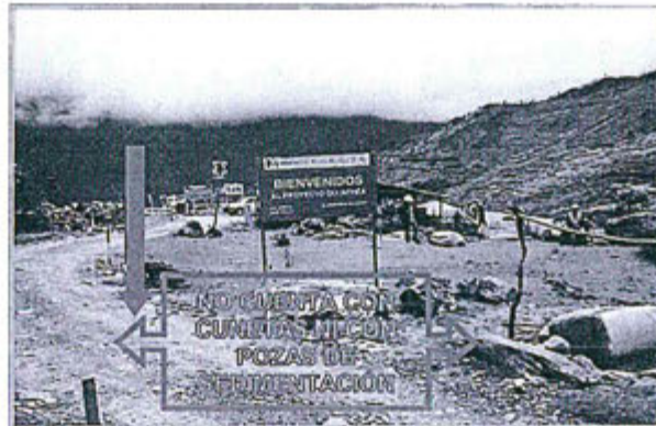
Fotografía N° 17 del Informe de Supervisión: Vía de acceso en el sector Minapampa, se observa que la vía no cuenta con las correspondientes cunetas de drenaje de precipitaciones, Recomendación N° 8, PE Ollachea, 2011.
