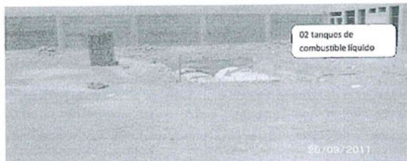
Foto N° 02: Localización de dos tanques nuevos
