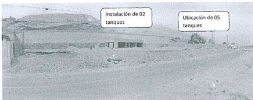
Foto N° 01: Vista Panorámica del Grifo de Corporación Okey
