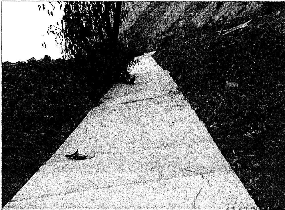
Fotografía 7. Canal de regantes protegido de material particulado
