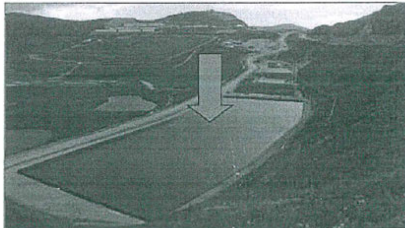
Imagen 2. Poza de sedimentación de agua de mina y cunetas de las rampas de acceso
