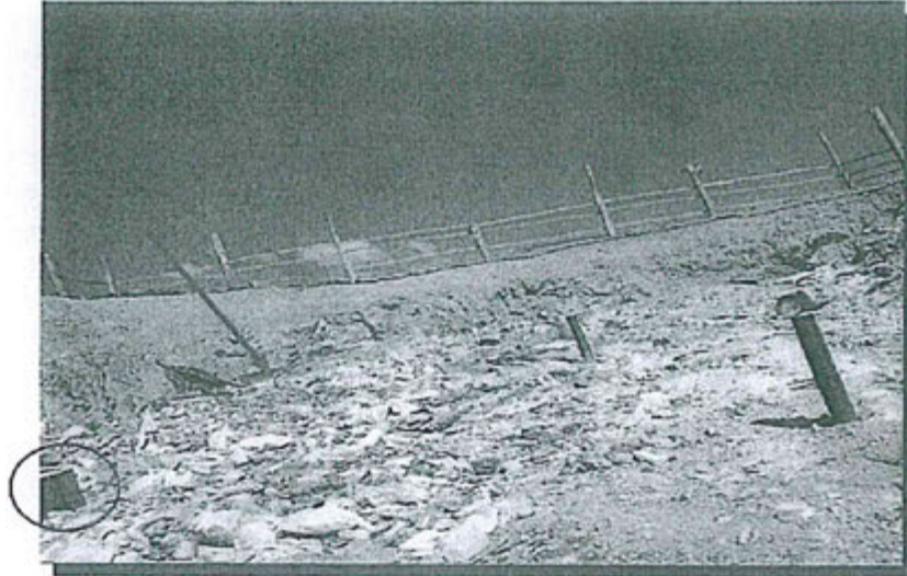
Foto 41: Vista del relleno sanitario sin impermeabilización, utilizado para disponer residuos sólidos domésticos, industriales y peligrosos.
