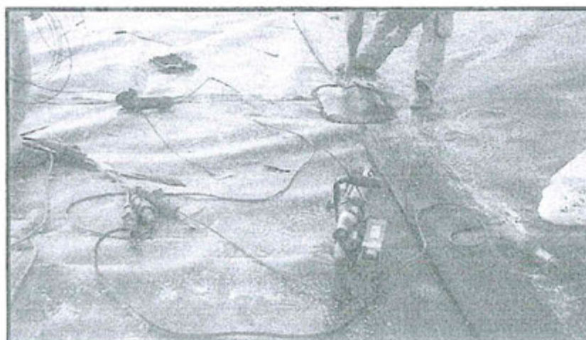
FOTOGRAFIA N° 4-04: SELLADO DE GEOMENBRANA.
