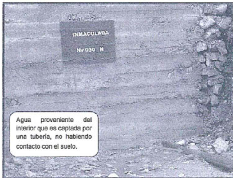
FOTOGRAFÍA N° 02: BOCAMINA TAPONEADA; AGUA PROVENIENTE DEL INTERIOR, QUE ES CAPTADA EN UNA TUBERÍA NO HABIENDO CONTACTO DEL AGUA CON EL SUELO.
