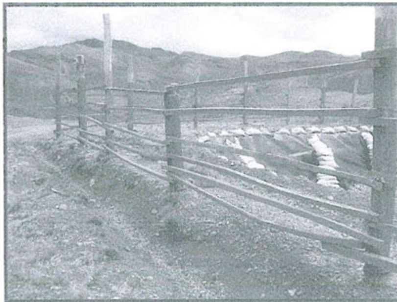
FOTOGRAFIA N°03: RELLENO SANITARIO CUENTA CON CANAL DE CORONACIÓN
