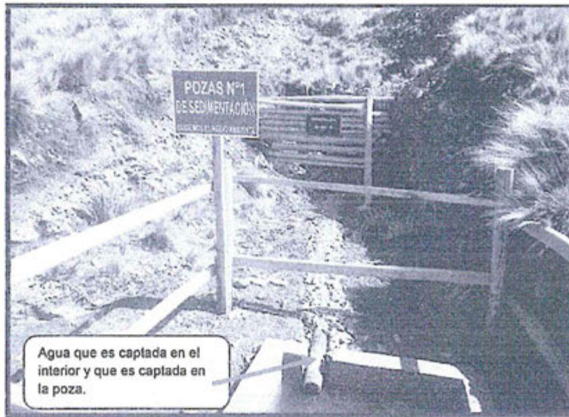
FOTOGRAFIA N° 02: TUBERÍA PARA LA EVACUACIÓN DEL AGUA CAPTADA EN LA POZA.
