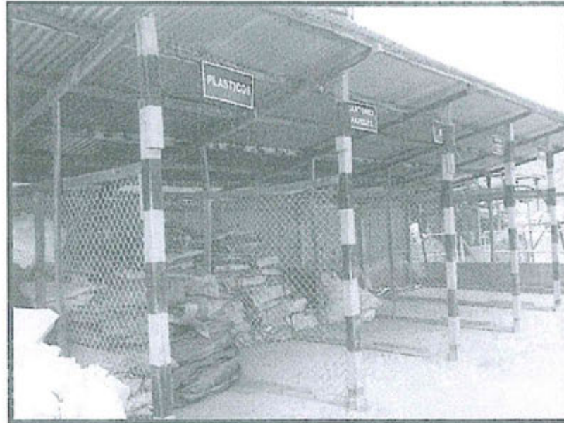
FOTOGRAFIA N°06: ESTACION DE TRANSFERENCIA DE RESIDUOS PELIGROSOS INDUSTRIALES.
