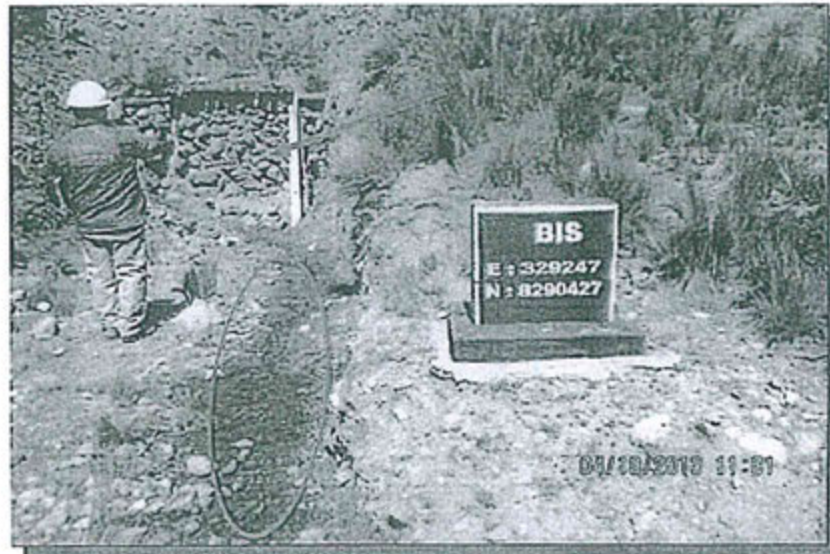
Foto 46: Bocamina del Nivel 060 con presencia de agua que sale del interior de la mina, sin tratamiento y vertidas por suelo natural..
