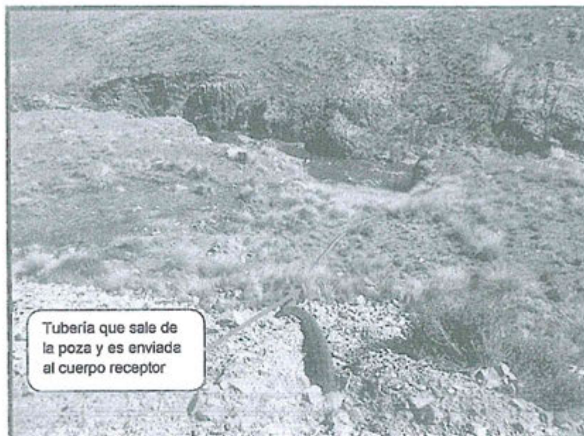
FOTOGRAFIA N°03: TUBERÍA QUE SALE DE LA POZA Y ES ENVIADA AL CUERPO RECEPTOR.
