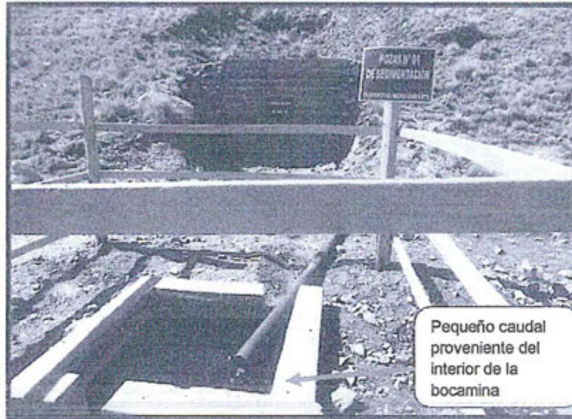
FOTOGRAFIA N° 01: CAUDAL PROVENIENTE DE LA BOCAMINA TAPONEADA.
