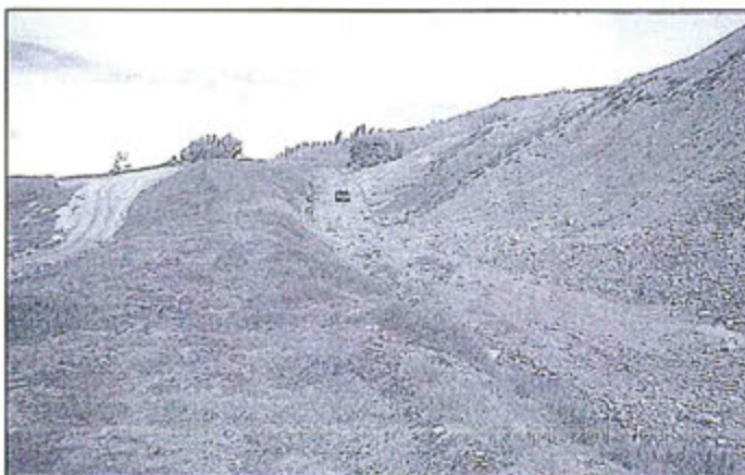
Fotografía N° 1. Vista fotográfica del muro de contención que evita el arrastre de sólidos de las pendientes de los botaderos en épocas de lluvias.
