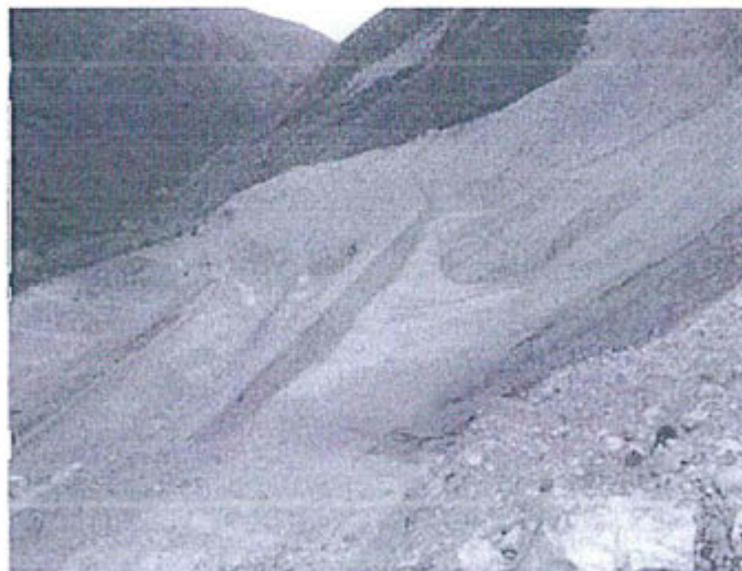
Nótese el muro de contención al pie del Botadero Norte de Tentadora.
