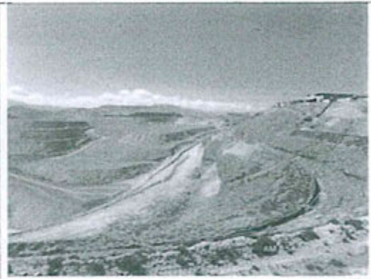
Otra vista fotográfica de la Infraestructura Hidráulica cochavara canal de mampostería
