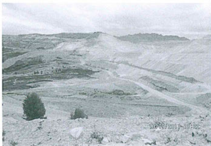
Foto 67: Vista del botadero 9 sin muro de contención.
