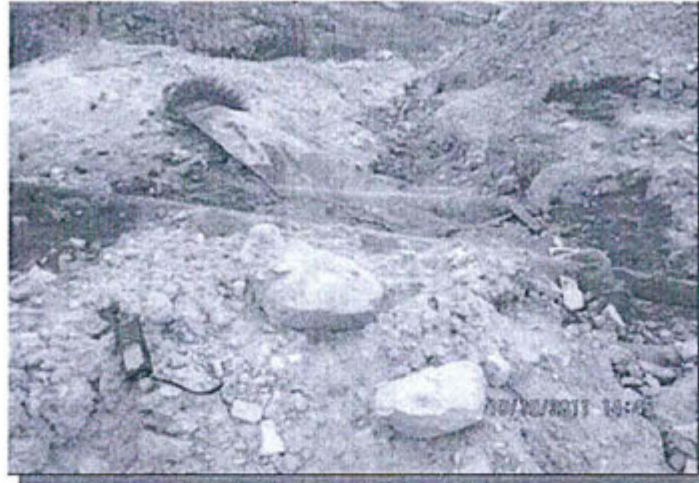
Foto 09: Disposición inadecuada de tierras contaminadas con aceites y grasas en la contrata Transflosa, al costado del taller de mantenimiento.
