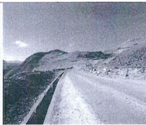
Infraestructura Hidráulica Tajo Seductora canal de concreto mampostería
