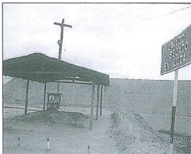
Fotografía N° 3 La contrata San Simón ha implementado el ambiente para secado de lodos de mantenimiento de equipos, mejorando así el manejo de lodos para su disposición final.
