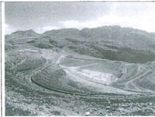
Infraestructura Hidráulica cochavara canal de mampostería aproximadamente 400 metros
