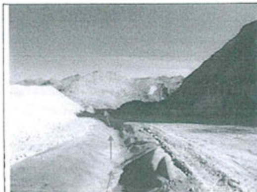
Infraestructura Hidráulica Clarita, canal perimetral con revestimiento de geomembrana en varios tramos. Aproximadamente 400 metros
