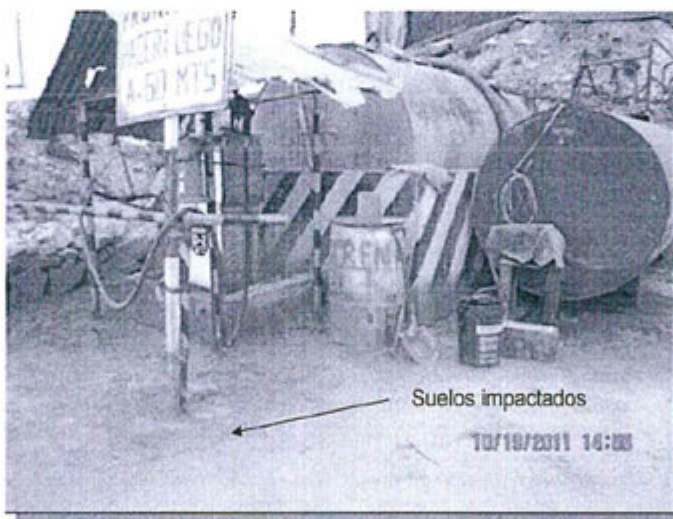
Foto 10: Presencia de derrames de combustibles en el suelo cerca al grifo de la contrata Transflosa.
