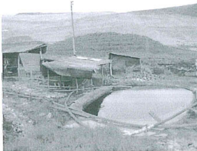
Vista panorámica de la poza de colección de aguas ácidas antes del tratamiento
