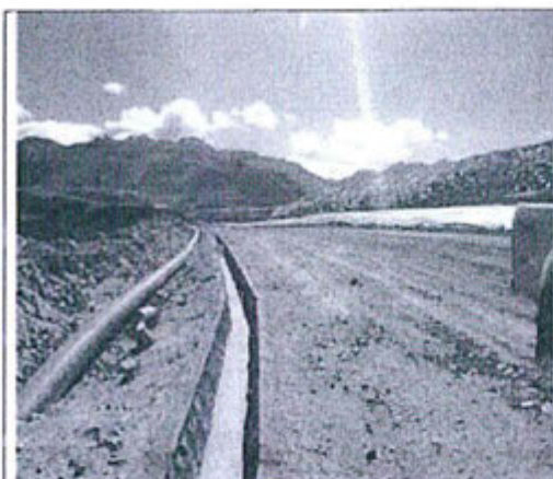
Infraestructura Hidráulica Tajo Seductora Canal de concreto y mampostería aproximadamente 450 metros
