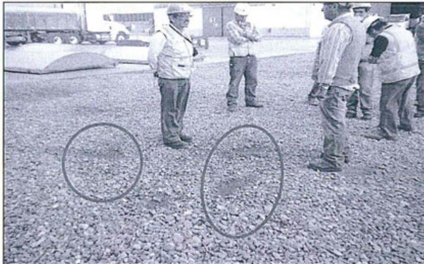
Fotografía N° 1: Área colindante al patio de maniobras del D. C. Salaverry, se observó concentrado sobre el suelo natural y cubierto con material de préstamo, no se ejecutaron las acciones correctivas para preservar la zona, Recomendación N° 6, D. C. Salaverry 2011.
