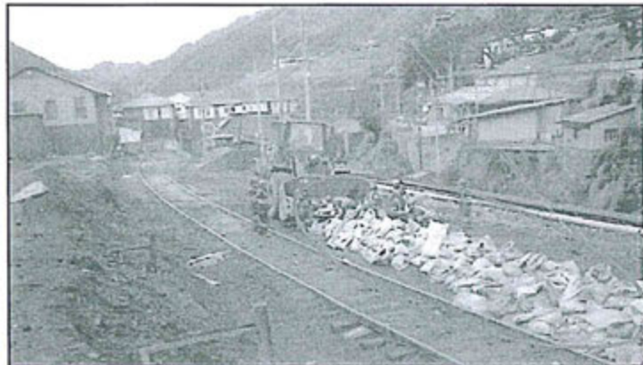
Fotografía N° 4: Vista cercana de los sacos en los que se almacenaban los suelos con relaves.
