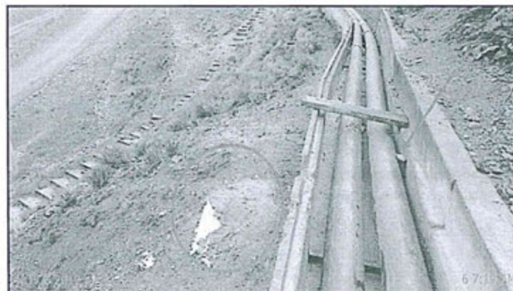
Fotografía N° 17: Vista del interior del canal de contingencia donde se aprecian las tuberías que llevan relave. Al lado adyacente de dicho canal se observa restos de un saco con presencia de relave en el talud de la ladera producto de la limpieza que se realizaba en la zona.
