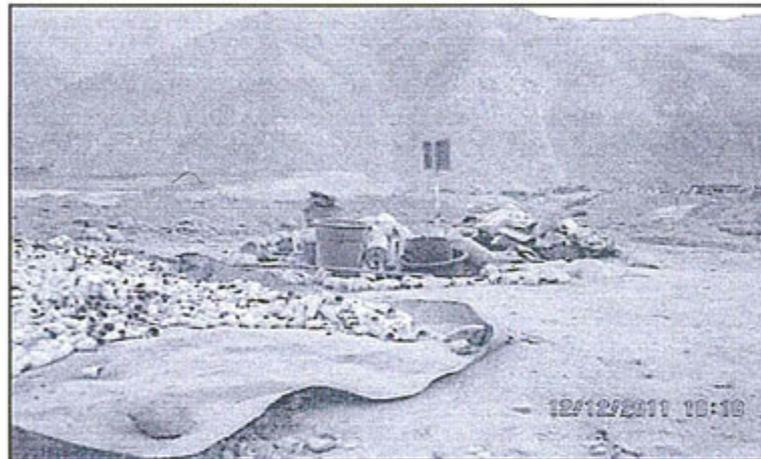
Foto N° 10.- Depósito de residuos sólidos tóxicos y peligrosos, sin cerco perimétrico ni techo, nótase los residuos sin orden ni identificación adecuada.
