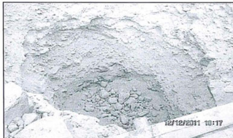
Foto N° 12.- Trinchera para residuos sólidos domésticos, sin las condiciones de un relleno sanitario.
