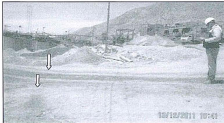
Fotografía N° 27.- La tubería de relaves cruza la vía (por debajo de la carretera, donde indican las flechas) sin tener alcantarilla de protección, estando sometida a la presión de los camiones que transitan por dicha vía en la quebrada Ajlajuito.
