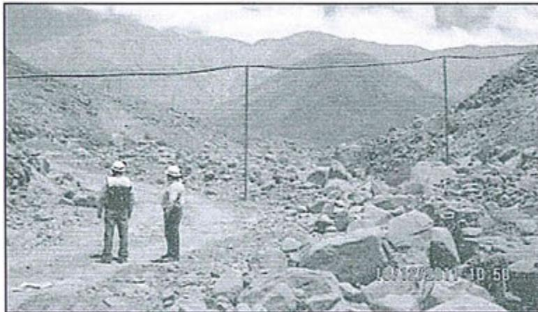
Fotografía N° 26.- Tubería de conducción de relaves, que no cuenta con un sistema de contención en caso de derrames, en la quebrada Ajlajuito.
