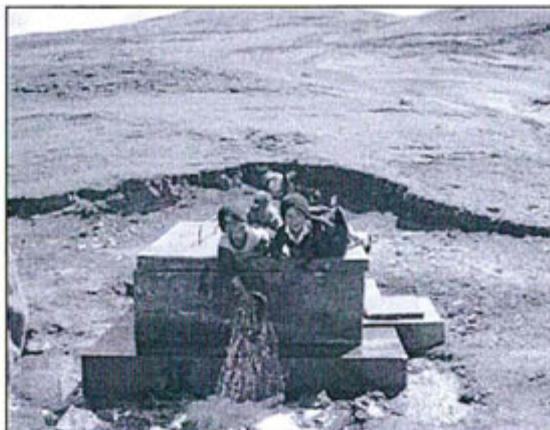
Pozo de abastecimiento de agua construido sobre el sondeaje de la Plataforma de perforación JOT-2008-10
