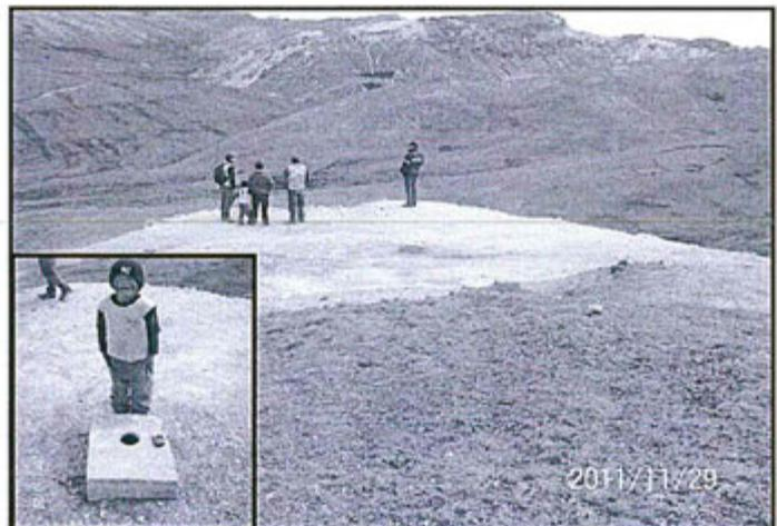
Fotografía N° 13 del Informe de Supervisión: DDH 1: azimut 215°, inclinación 55° y profundidad de 355 m. Plataforma JOT-2008-01 de 11.20 m x 11.90 m, no ha sido remediada.
