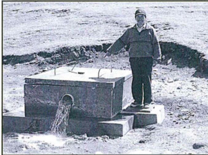
Fotografía N° 15 del Informe de Supervisión: Plataforma JOT-2008-10 de 9.80 m x 9.80 m, sin obturar que interceptó agua artesiana; no ha sido remediada.
