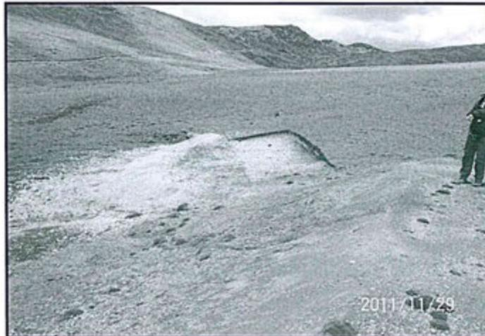
**Fotografía N° 22 del Informe de Supervisión:** Las pozas de lodos de la plataforma JOT-08-06 no han sido cerradas ni remediadas.
