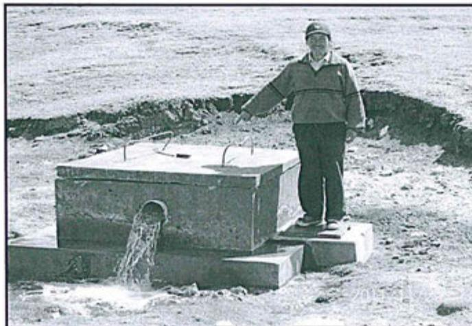
Fotografía N° 15 del Informe de Supervisión: Plataforma JOT-2008-10 de 9.80 m x 9.80 m, sin obturar que interceptó agua artesiana; no ha sido remediada.
