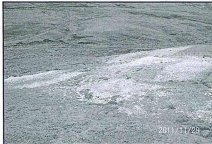
**Fotografía N° 23 del Informe de Supervisión:** Las pozas de lodos de la plataforma JOT-08-03 no han sido cerradas ni remediadas.
