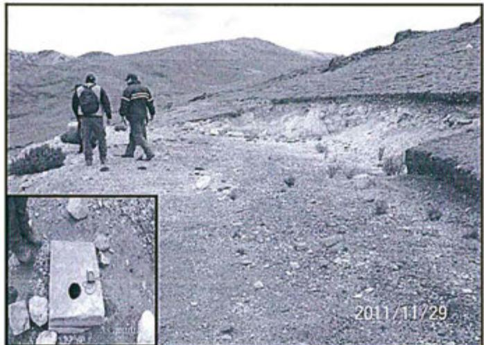
Fotografía N° 11 del Informe de Supervisión: DDH 8 cuya obturación carece de rótulo de identificación en el dado de concreto. Plataforma JOT-2008-08 de 14.00 m x 9.10 m, no ha sido remediada.
