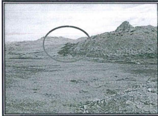
Foto N° 3.- Observación N° 02. Depósito de desmontes Don Pablo, al lado sur, se observa acumulación de top soil mezclados con desmontes al pie del talud y sin conservar inclinación apropiada.
