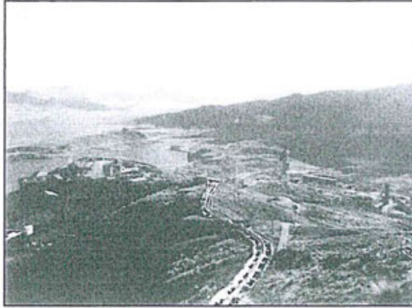
Sistema para contingencias en la tubería que transporta relave, con vista hacia la Planta de Relleno Hidráulico
