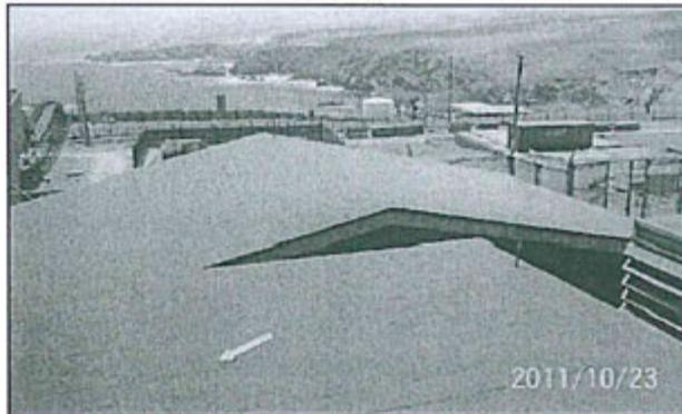
Fotografía N° 11 del Informe de Supervisión: Capa de material particulado de concentrado de cobre sobre los techos de la sala MCC y del laboratorio próximos al almacén de concentrado SMCV y Xstrata.
