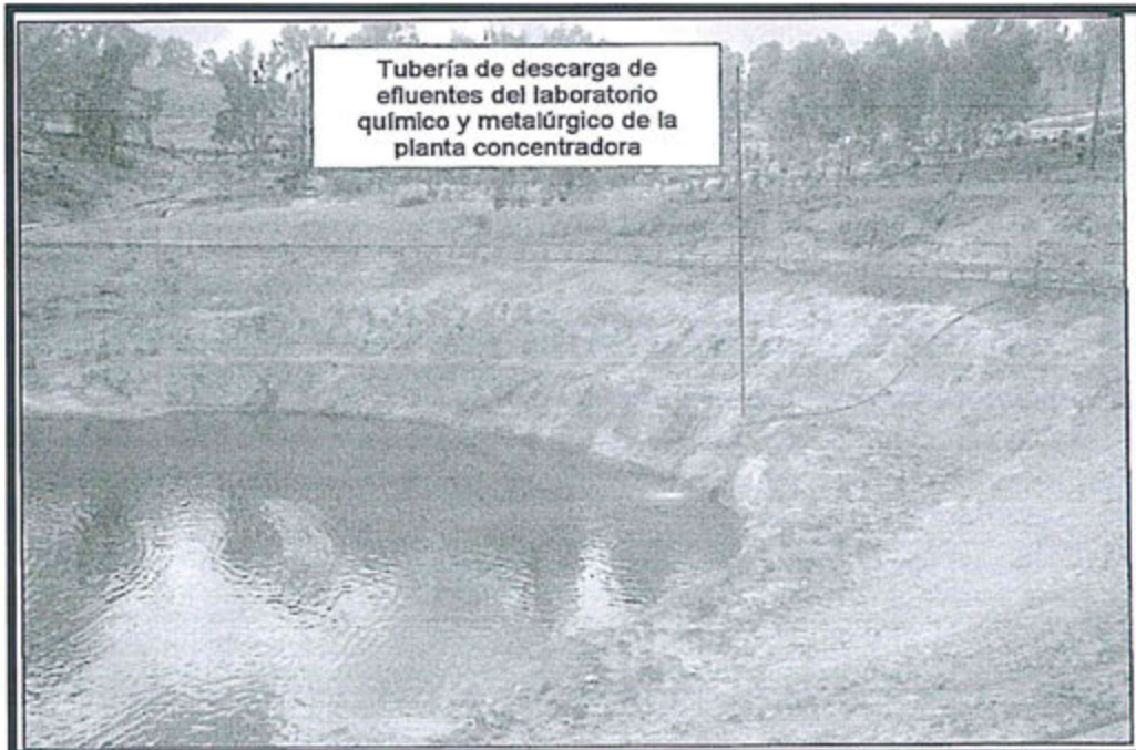
Fotografía N° 3: poza de grandes eventos que almacena aguas de los efluentes de los laboratorios químico y metalúrgico, pertenecientes a la Planta Concentradora Shorey. No cuenta con geomembrana de impermeabilización
