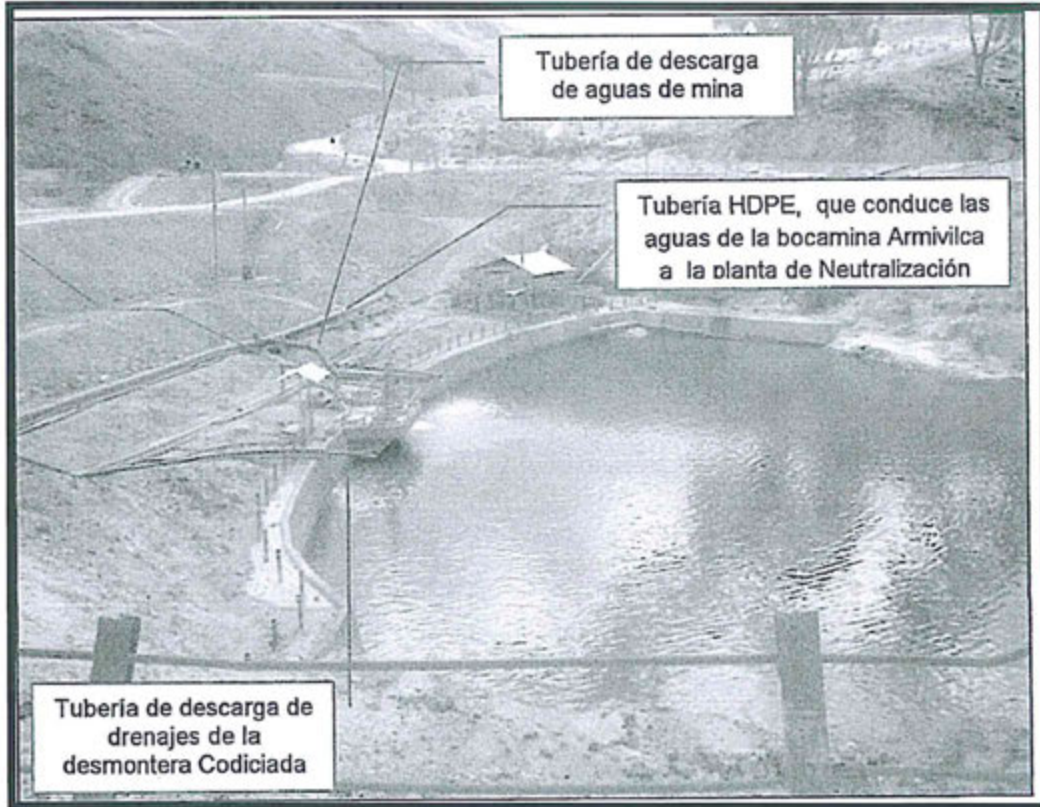
Fotografía N° 2: Poza de grandes eventos que almacena aguas de mina (provenientes de la bocamina Almirvilca) y del drenaje de la desmontera Codiciada. No cuenta con impermeabilización.
