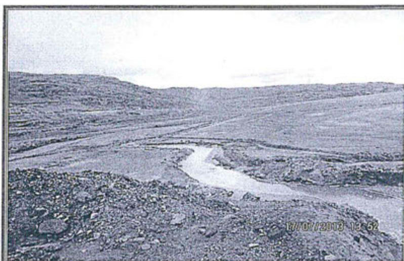
Fotografía N° 35: Depósito de Relaves Quiulacocha. En la vista las aguas ácidas del Depósito de Desmonte Excélsior son derivadas hacia el Depósito de Relaves Quiulacocha.
