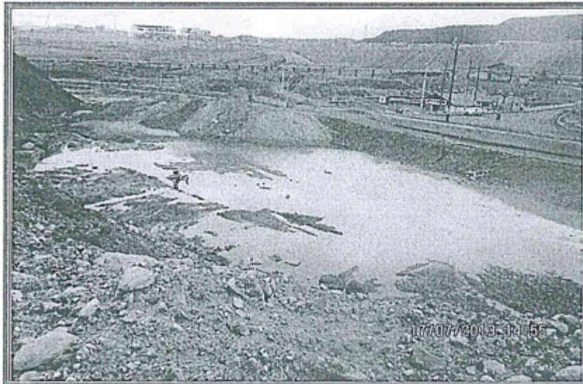
Fotografía N° 29: Lado Oeste Depósito de Desmonte Excelsior. Al pie del talud oeste del Depósito de Desmonte Excelsior, adyacente a la Planta de Neutralización de Empresa Administradora Cerro S.A.C., se produce la filtración de agua ácida que discurre hacia el Depósito de Relaves Quiulacocha.
