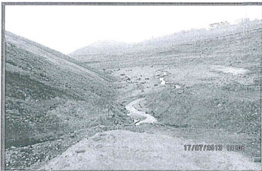
Fotografía N° 31: Lado Oeste Depósito de Desmonte Excelsior. Las aguas de filtración por el talud oeste de Depósito de Desmonte Excelsior, adyacente a la Planta de Neutralización de Empresa Administradora Cerro S.A.C., discurre hacia el Depósito de Relaves Quiulacocha.
