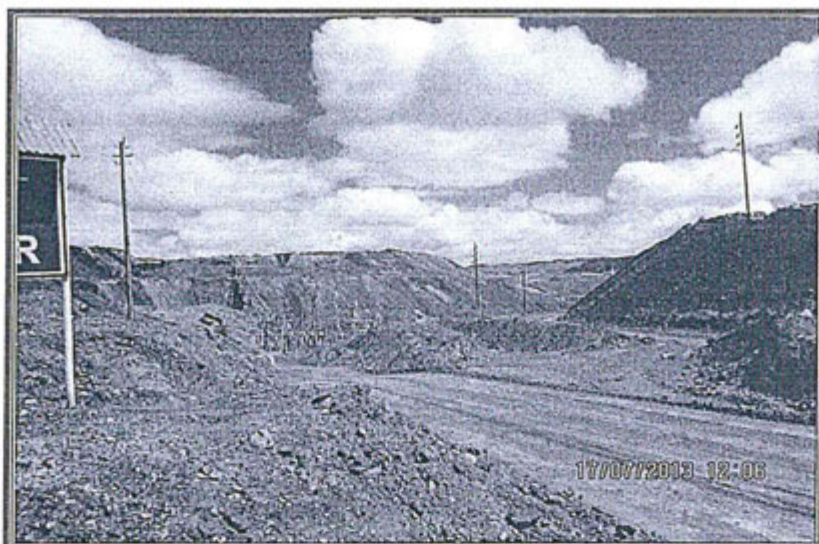
Fotografía N° 6: Hallazgo N° 1 Depósito de Desmonte Excelsior. En la Supervisión se constató que en el Pasivo Ambiental Depósito de Desmonte Excelsior, no se realiza ninguna actividad de cierre. Talud Norte.
