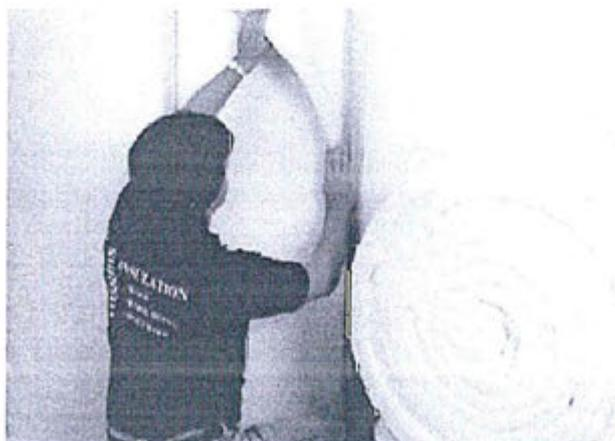
Fotografía 1: Trabajo de revestimiento de las paredes (Folio N° 444)
