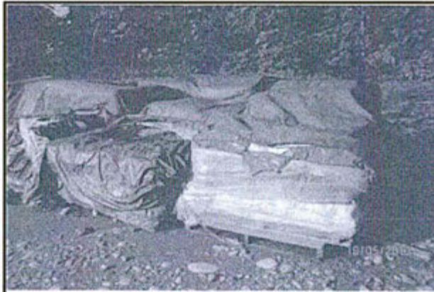
Figura N° 35. En el registro fotográfico se evidencia el almacenamiento de productos químicos sólidos (Sodium Formate) colocados sobre un área sin impermeabilizar. Ubicación: Campamento Base Malvinas.
