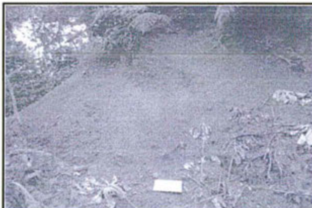
Figura N° 17. En el registro fotográfico se evidencia otra vista de la erosión de suelo en un talud del flow line, en la coordenada 749743 E y 8684132 N (referencia trayecto del Km 39 hacia la locación Cashirari 1), área afectada aproximadamente de 40 m 2 .
