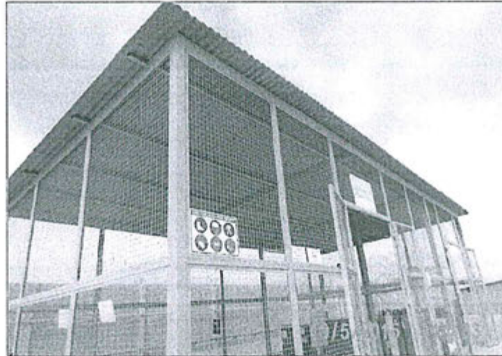
Fotografía 1: Almacén de materiales y residuos peligrosos culminado (Folio 636)
