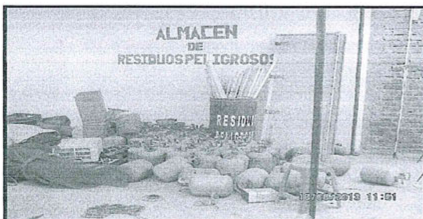
Foto N° 21. Verificación de la zona de almacenamiento de residuos peligrosos, Sin rotulado. Toma 1.
