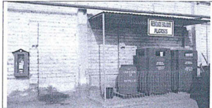
Fotografía N° 1: Almacén central de Residuos Sólidos Peligrosos, nótese en la fotografía que esta cuenta con una base de losa de concreto, el área está delimitada, debidamente señalizada y rotulado en cada recipiente indicando el tipo de residuo a depositar; así mismo cuenta con una extintor cercano a esta área y un balde con arena a fin de controlar una posible eventualidad.
