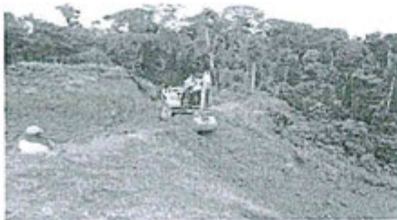
Foto N° 15: Ejecución de trabajos mecánicos de estabilización
