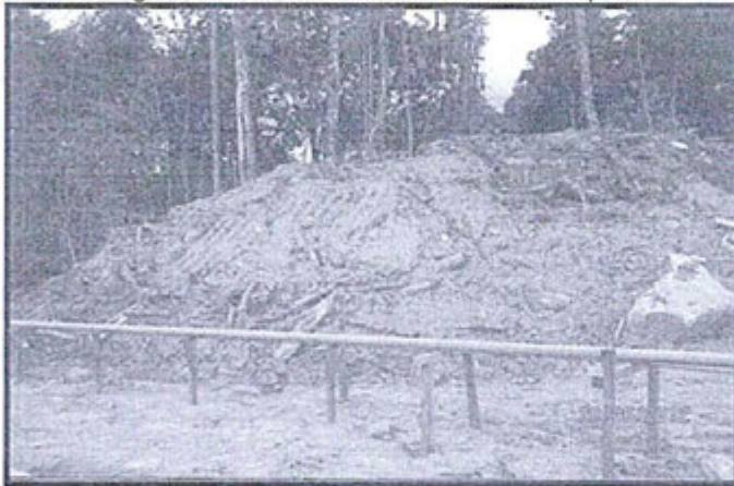
Fotografía N° 4: Inadecuada conservación del topsoil
