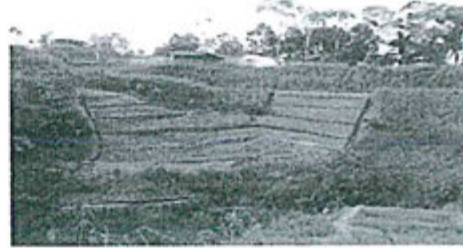
Foto N° 08: Vista final del área al finalizar los trabajos de control de erosión
