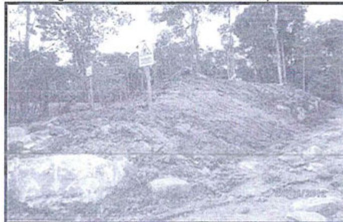
Fotografía N° 5: Inadecuada conservación del topsoil
