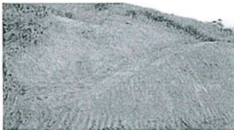
Foto N° 11: Ejecución de trabajos proyectados
