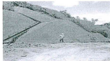
Foto N° 12: Estado del sector al finalizar los trabajos de control de erosión
