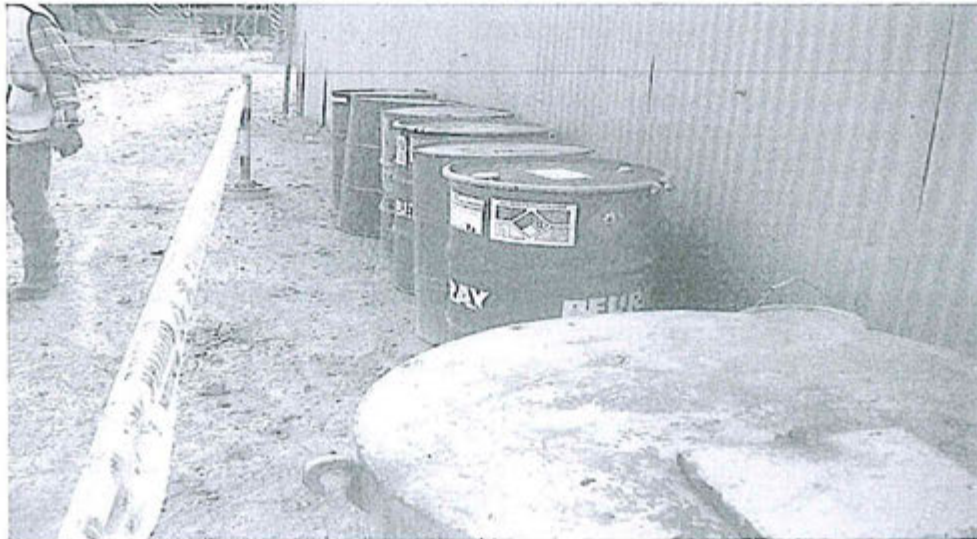
Fotografía N° 55.- Supervisión Regular 2012.- Observación N° 1.- En el patio de la planta concentradora, se observaron recipientes usados vacíos y otros llenos (nuevos) conteniendo aceites y grasas, dispuestos sobre suelo natural y en lugares no adecuados para su almacenamiento.
