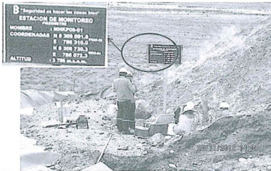
Fotografía N° 67.- Punto de muestreo de agua subterránea en el Piezómetro NHKP09-01 (Punto de control al pie del dique de la relavera 4).
