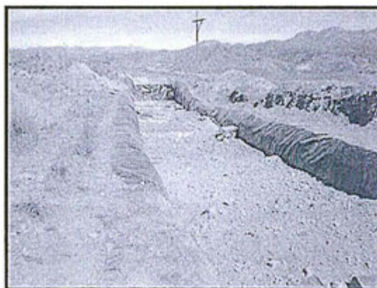
Fotografía N° 6; Relleno Sanitario –Municipal de Orcopampa
