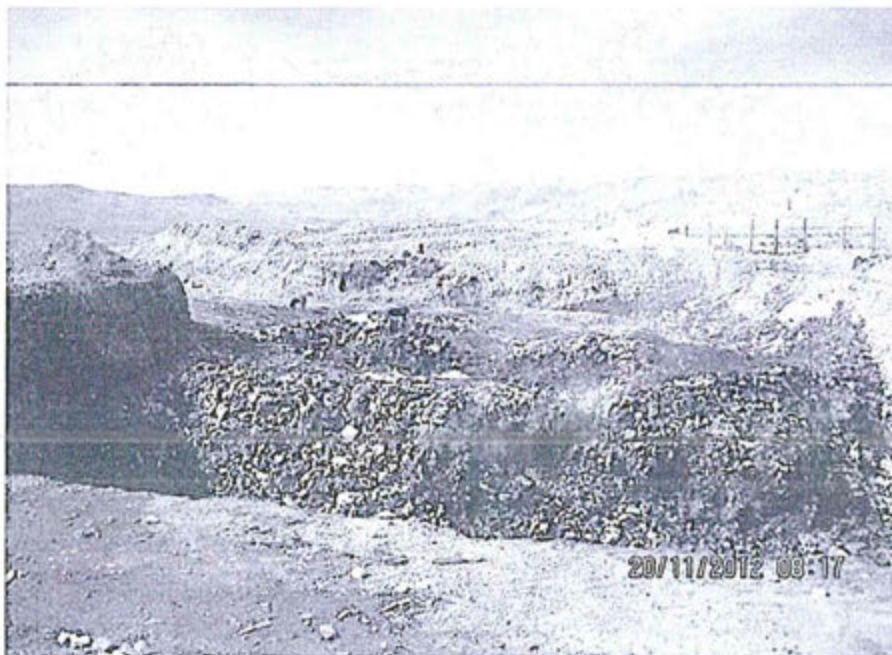
Fotografía N° 61.- Supervisión Regular 2012.- Observación N° 5.- La mina dispone sus residuos sólidos en el botadero municipal de residuos sólidos de Orcopampa, el cual no cumple con requisitos para un relleno sanitario (disposición en trincheras sin sistemas de captación de lixiviados, sin impermeabilización, sin chimeneas de venteo; y quema de residuos).
