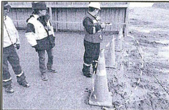
Fotografía.- 52.- Observación N° 03 (supervisión regular 2012): el área de lavadero de equipos de carguío y acarreo, en la parte posterior, no cuenta con el canal de captación, se observa la formación de aguas estancadas con lodos.
