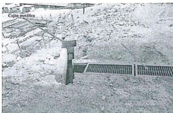
FOTO N° 55: Cumplimiento de Recomendación N° 6, 2012: En la sección chancado se hizo limpieza del canal de aguas residuales, se colocó una rejilla metálica y se acondicionó un cajón metálico y mediante tubería de 2" de diámetro se derivan dichas aguas al cajón de relaves.
