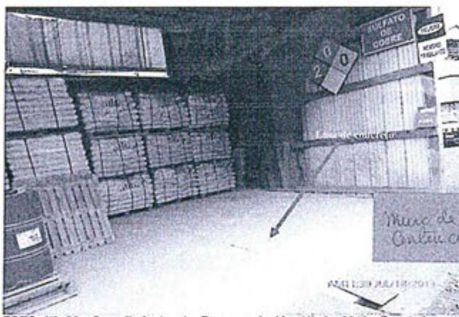
FOTO N° 60: Cumplimiento de Recomendación N° 9, 2012: En el área de almacenes generales en la zona donde se encuentra el Sulfato de Cobre, se ha construido una base de concreto con su contención.
