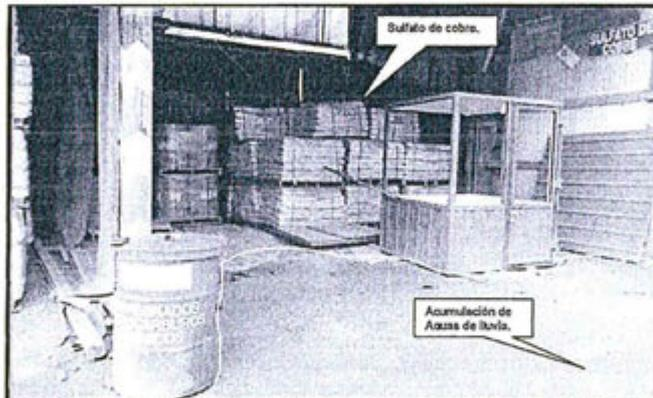
Fotografía.- 64.- Observación N° 09 (supervisión regular 2012): área de Almacenes Generales, se observó que la zona de almacenaje de bisulfito de sodio y sulfato de cobre, no cuenta con una base ni muro de contención para evitar derrames e ingreso de agua de lluvia. Obsérvese la acumulación de agua por efecto de las lluvias.
