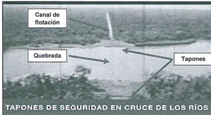
Foto N° 6. Vista panorámica del cruce de una de las quebradas y el canal de flotación, del video "Conoce cómo se construyeron el Oleoducto Norperuano y los canales de flotación".
