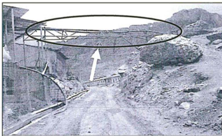
Fotografía N° 1: Tubería de transporte de relave de la Planta en dirección al depósito de relave, no cuenta con sistema de contingencia.
