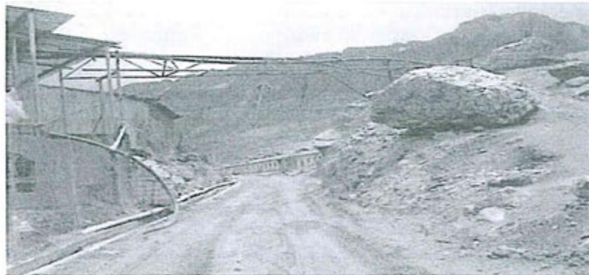
**Fotografía N° 1:** Tubería de transporte de relave de la Planta en dirección al depósito de relave, no cuenta con sistema de contingencia.
