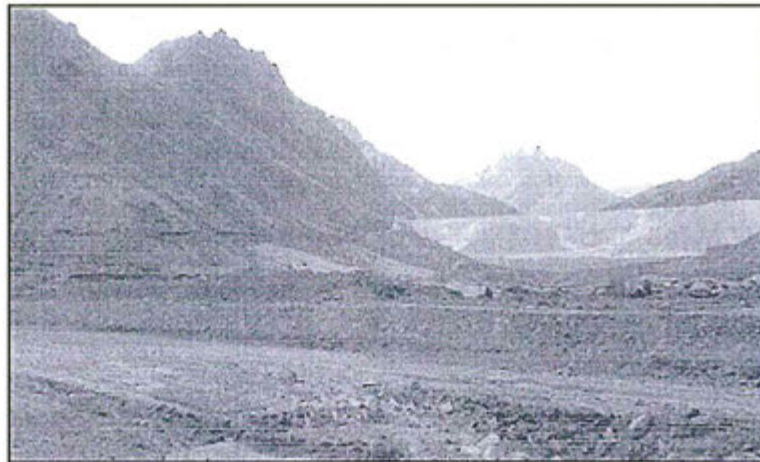
Fotografía N° 16: Vista del depósito de desmonte y materiales del subsuelo han sido retirados de la orilla de la quebrada Chinchán, sin embargo, falta culminar con el perfilado en un sector del mencionado depósito.
