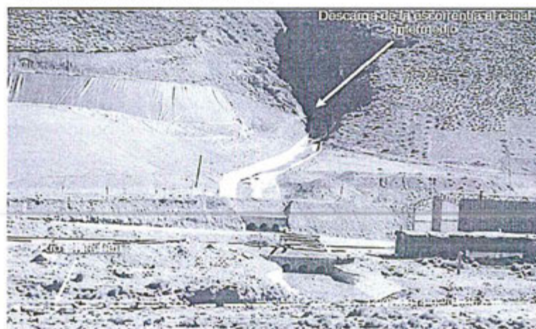
"Fotografía N° 7: Depósito de Relaves Chinchán – Canal de Coronación. Quebrada Intermedia al norte del depósito de relaves, descarga sus aguas al río Chinchán".
