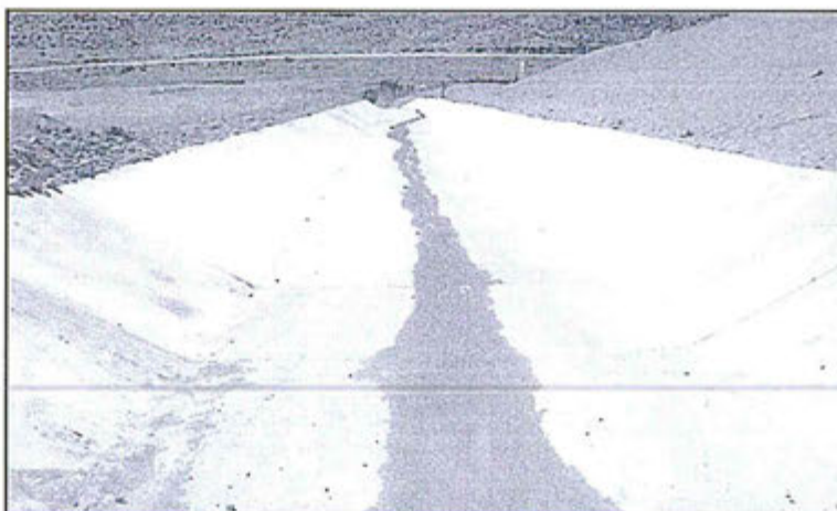
"Foto N° 3: Vista del trazo final del canal de encausamiento".
