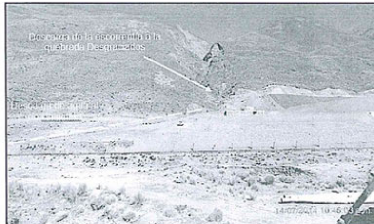
"Fotografía N° 5: Depósito de relaves Chinchán. Quebrada Desgraciados al sur del depósito de relaves Chinchán, descarga sus aguas al río Chinchán".
