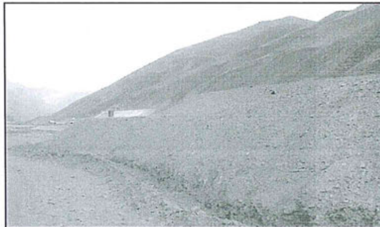
Fotografía N° 14: Vista del depósito temporal de suelos orgánicos (top soil), se observa su compactación, perfilado y canal de coronación.
