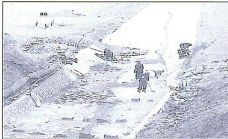
"Foto N°1: Vista de los trabajos en el canal de encausamiento".
