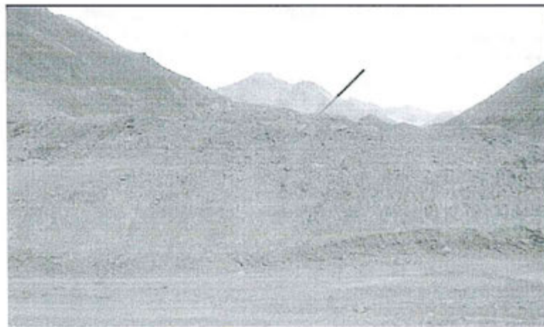
Fotografía N° 15: Vista del sector del depósito temporal de suelos orgánicos (top soil), donde falta el perfilado.
