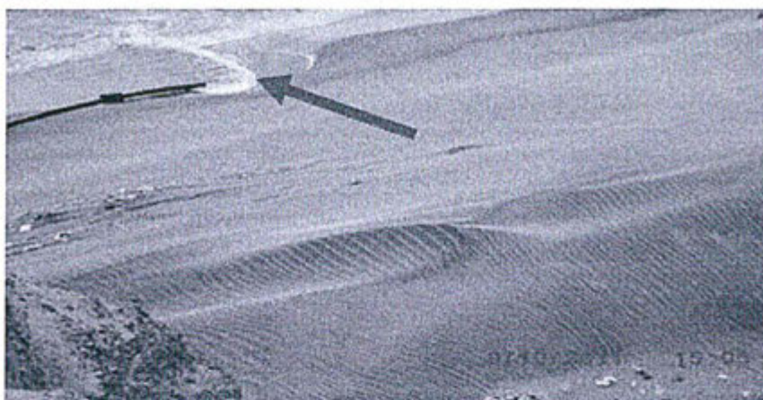
FOTO 50: Sistema de descarga de efluentes domésticos, obsérvese la disposición en el borde de la playa del mar, incumpliendo lo que indica su EIA.
