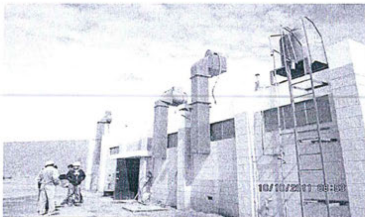
FOTO 66: Extractor de polvos y gases sin lavador de gases del laboratorio de análisis químicos de mina
