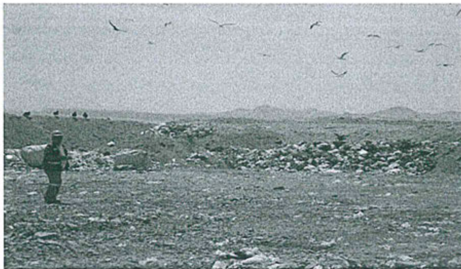
FOTO 15: Botadero sanitario sin impermeabilización del suelo y sin chimeneas..
