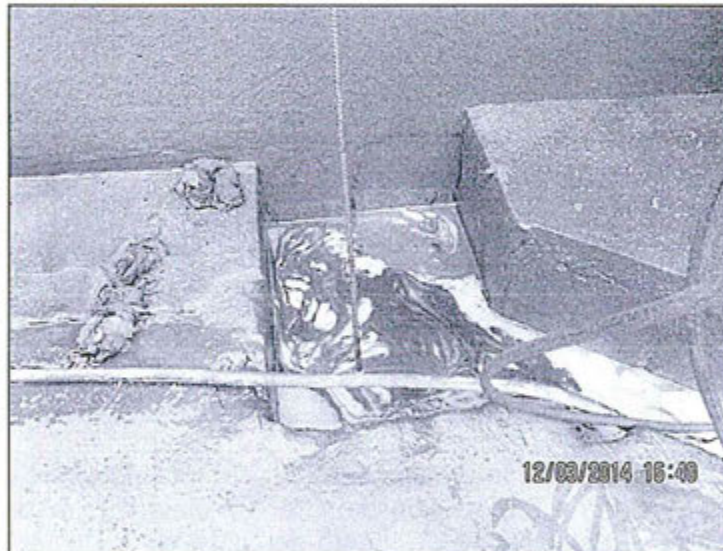
Fotografía N° 3: Durante la supervisión del 10 al 13 de marzo del 2014 se aprecia la canaleta y caja de registro del taller central sin presencia de lodos en el interior, luego la solución es derivada a los skimmer para la separación de física por decantación de hidrocarburos y agua (Observación N°11 de la Supervisión Regular 2011).
