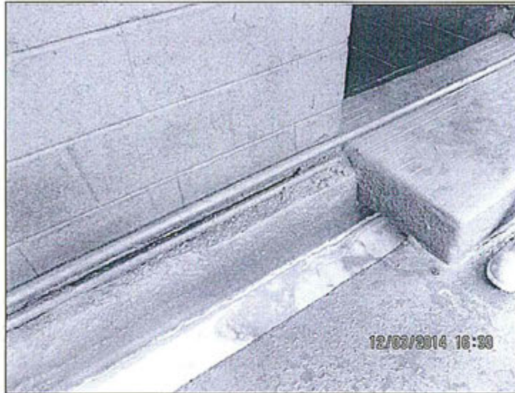
Fotografía N° 1: Durante la supervisión del 10 al 13 de marzo del 2014 se aprecia la canaleta del taller central sin presencia de lodo en el interior (Observación N°11 de la Supervisión Regular 2011).
